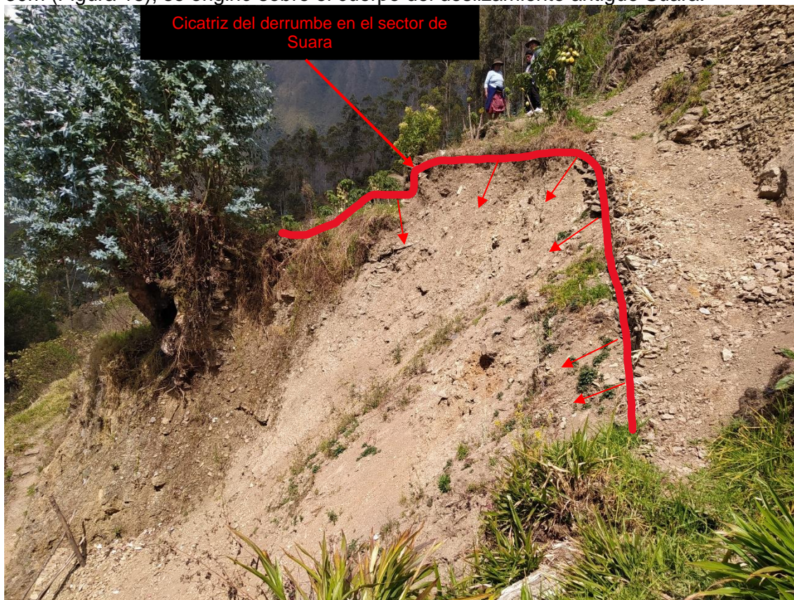
Agrietamiento 15: Derrumbe sobre depósitos coluvio-deluviales en coordenadas UTM E: 450799, N: 8413460.
