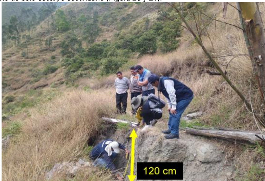
Figura 20. Escarpe secundario (ESP2) en el sector de Pampa Tuana (UTM E: 450994, N: 8415410 y E: 451037)
