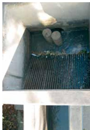
**Figura N° 2.39:** Detalle de la trampa de rejillas.
