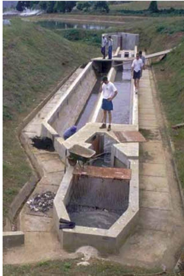
**Figura N° 2.28:** Infraestructura de un sistema de pretratamiento de aguas residuales, donde se observa una rejilla y un desarenador, diseñados para una laguna facultativa.
