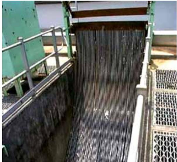
**Figura N° 2.7:** Las cámaras de rejas permiten la retención de residuos sólidos y material grueso previo al ingreso a las unidades de tratamiento primario.
