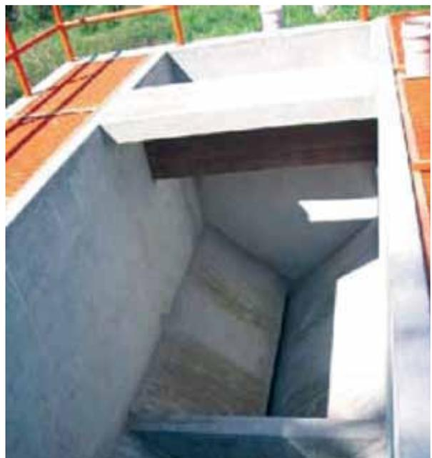
Figura N° 2.14: Tanque Imhoff vista superior.
