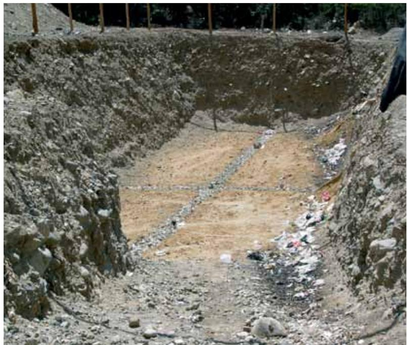
Figura N° 3.50: Imágenes de un relleno sanitario manual en la ciudad de Caraz.
