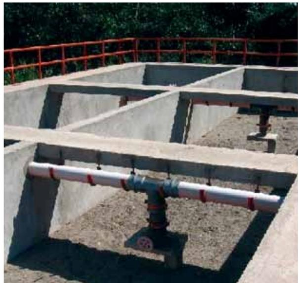
Figura N° 2.13: Lecho de secado para el tratamiento de lodos procedente de un Tanque Imhoff.
