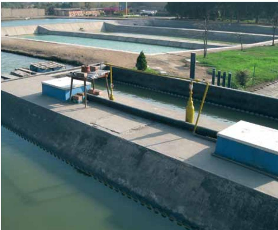
Figura N° 2.42: Zonas de sedimentación de efluentes en el RAFA y lagunas de acabado.
