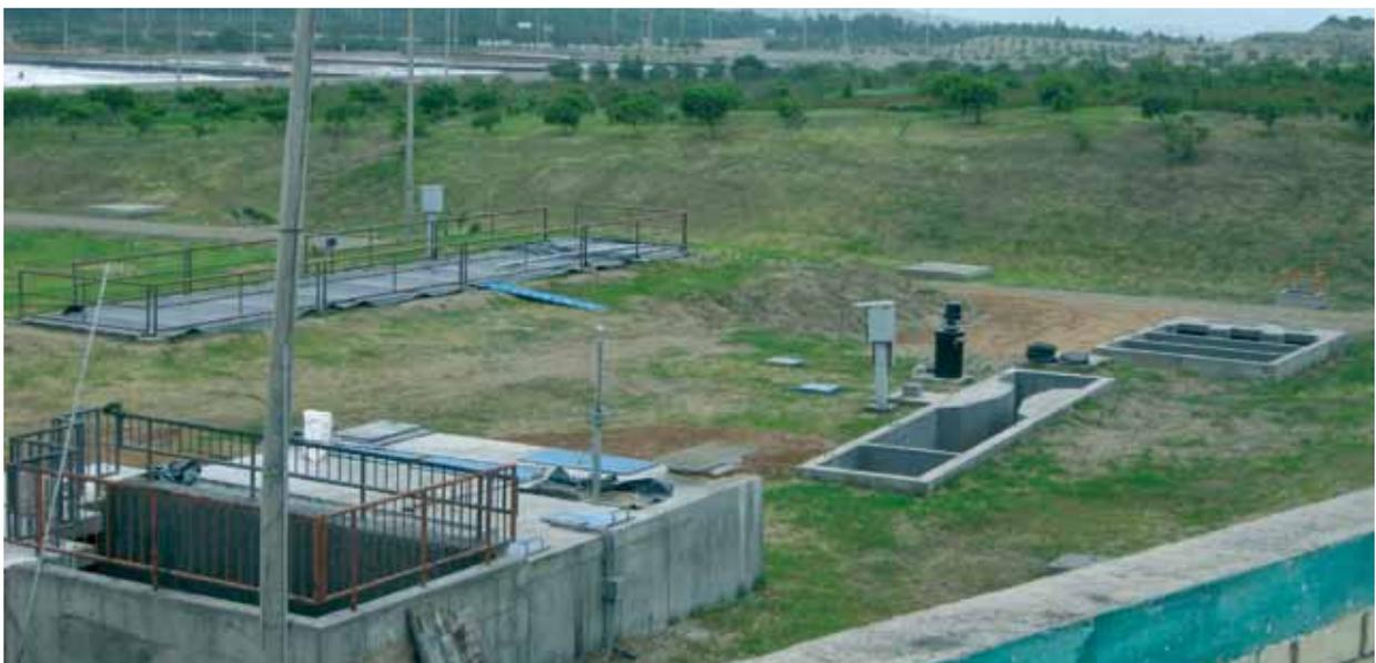
**Figura N° 2.35:** Infraestructura de tratamiento preliminar de las lagunas aireadas con aireadores mecánicos del Parque Zonal Huáscar.
