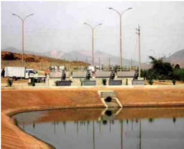
**Figura N° 2.5:** Vista de una planta de tratamiento que emplea lagunas de estabilización para el tratamiento de aguas residuales. El diseño hidráulico de ingreso y salida a las lagunas es importante para mejorar la eficiencia de los procesos de tratamiento en este tipo de unidades.
