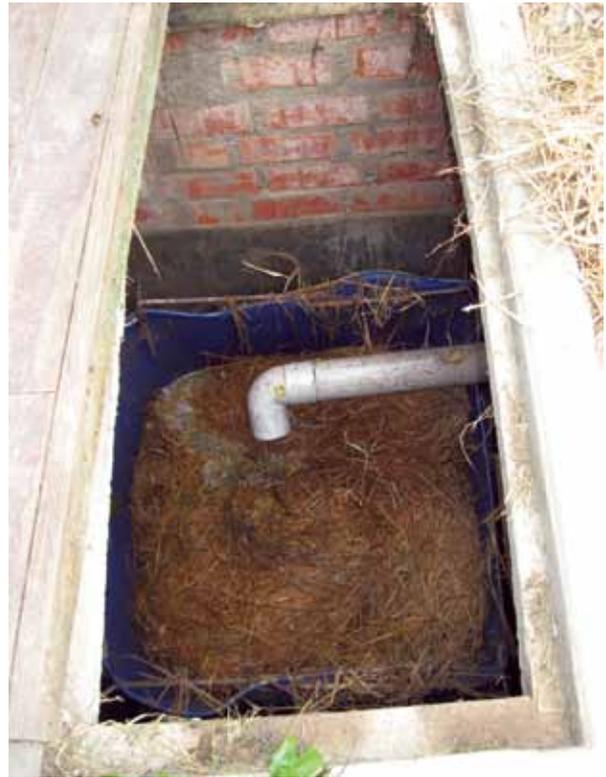
**Figura N° 2.23:** Cámaras de tratamiento preliminar del humedal artificial vertical, donde una de las cámaras de reposo está siendo aprovechada para hacer compost con la materia orgánica.
