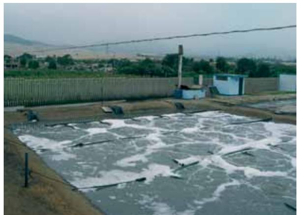
**Figura N° 2.34:** Sistema de lagunas aireadas que emplea sistema de difusores de aire comprimido. Se suelen emplear toberas o difusores de burbuja tipo disco. La debilidad del sistema aireado radica en que no asume la visión de ecoeficiencia al emplear energía eléctrica que favorece el calentamiento global.
