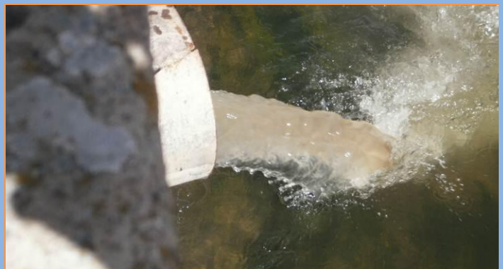
Foto N° 06; Evacuación de las Aguas Residuales de Huancané, en forma Directa al Río Huancané
