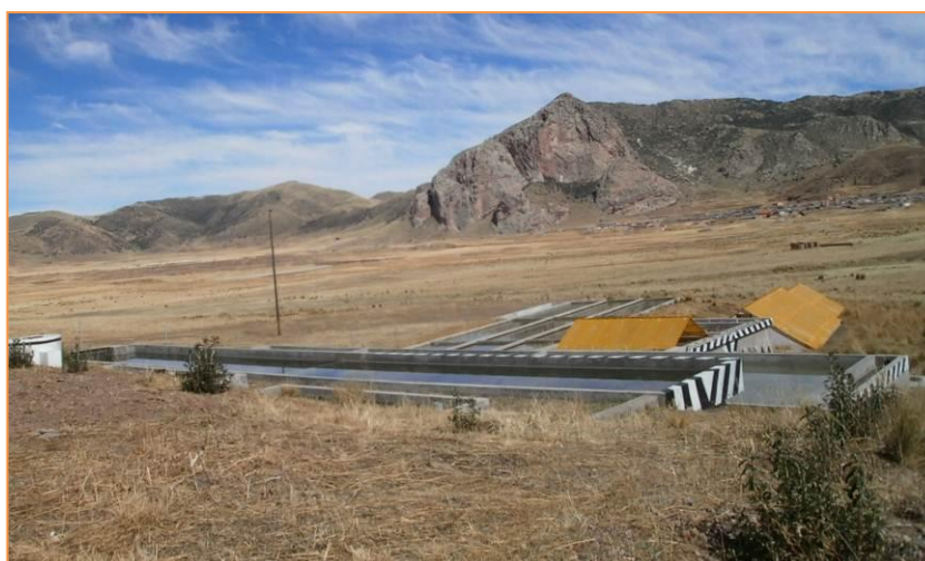
Foto N° 7 Sistema de Tratamiento de N° 4 José Domingo Choquehuanca – Azángaro (Cuenca del Río Pucará)
