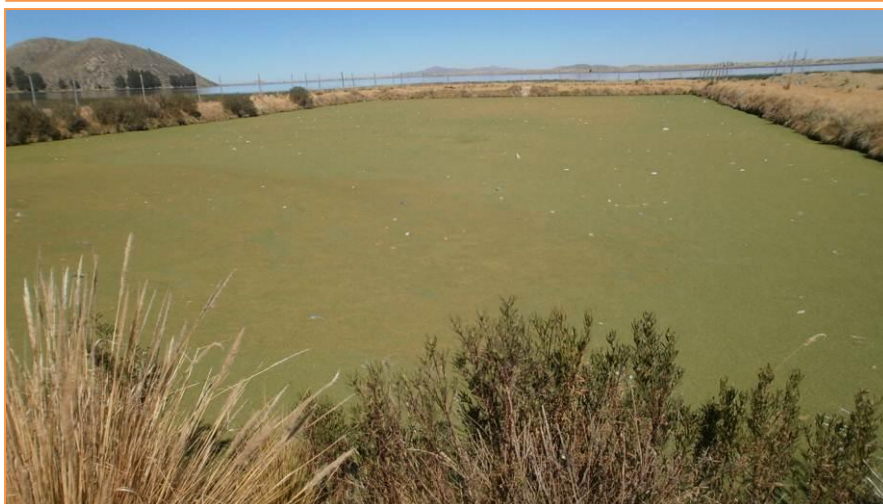
Foto N° 9 Sistema de Tratamiento de Arapa – Azángaro (Intercuenca del Río Ramis)
