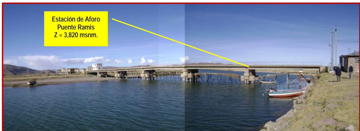
Figura N° 11.1 Estación de Aforo del río Ramis
