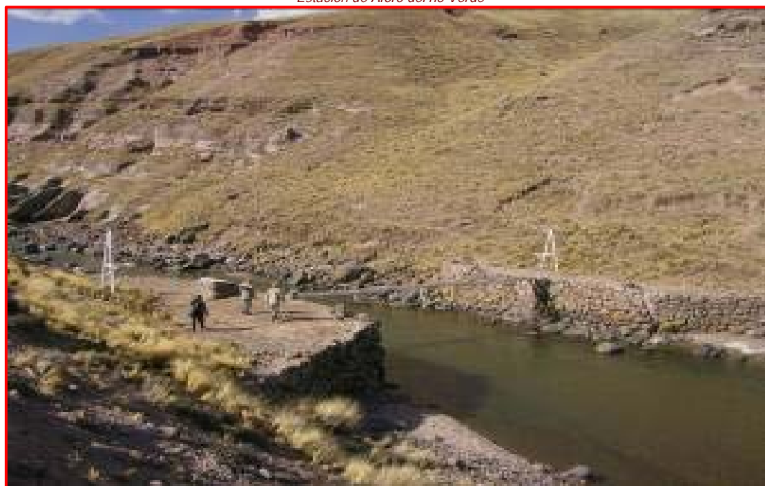
Figura N° 11.4 Estación de Aforo del río Verde
