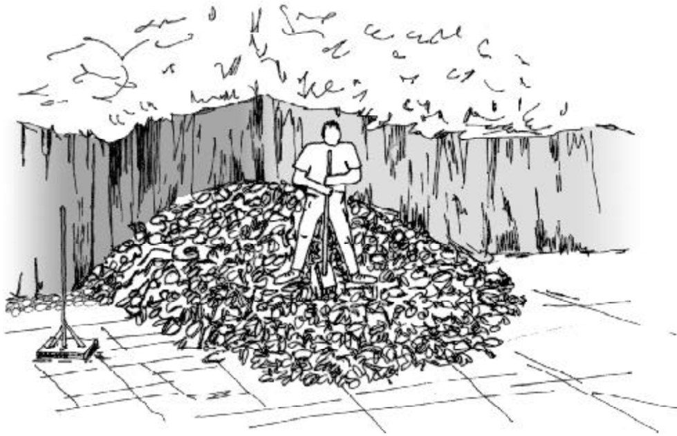
Figura 7.16 Compactación de los RSM con un pisón de mano
