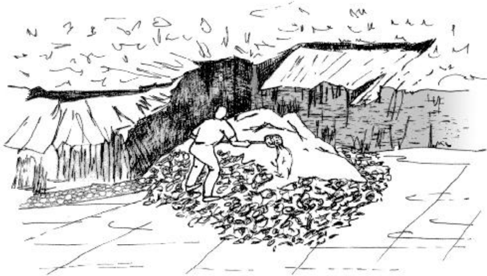
Figura 7.18 Cubrimiento de los RSM con tierra
