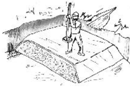
3. Inicio de la operación del relleno
