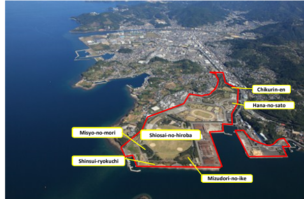
Relleno en la Bahía de Minamata Fotografía: Museo Municipal de la Enfermedad de Minamata
