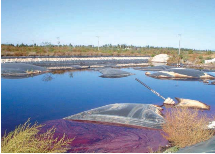
Relleno Sanitario Bordo Poniente. Lixiviados en celda.
