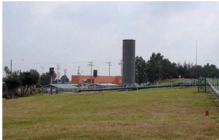
Relleno Sanitario Clausurado Prados de la Montaña. Quemador para el gas generado.
