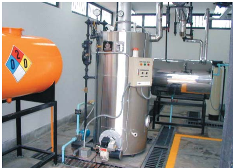
Módulo de Residuos Hospitalarios. Hospital Nacional de Collique.
