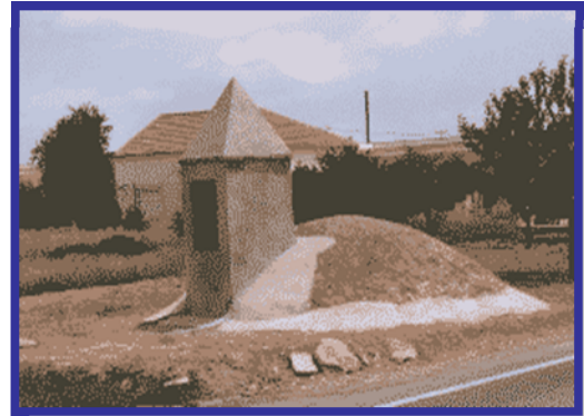
Figura 1.4: Los aljibes de Fuente Álamo fueron prácticamente las únicas fuentes de abastecimiento de la población de los alrededores hasta finales de los años 50 [Ref. 1]
