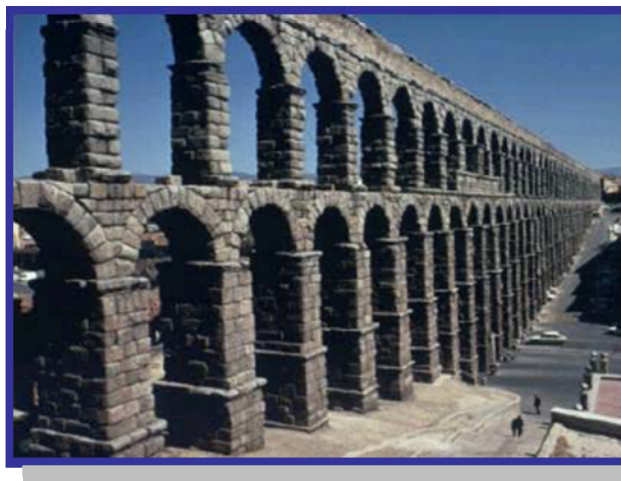
Figura 1.5: Acueducto romano siglo XVII [Ref. 1]
