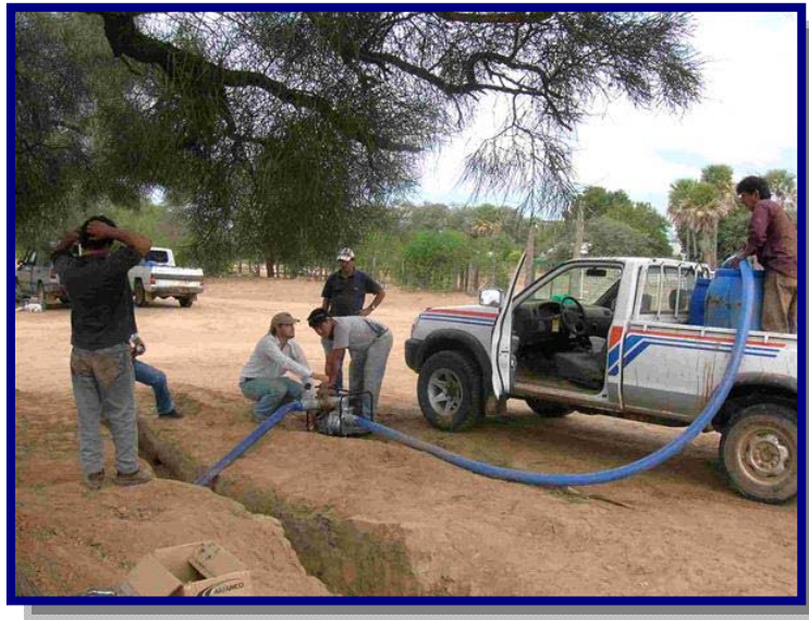
Figura 7.21: Prueba de Presión [Ref. 28]
