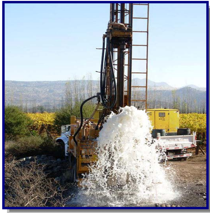
Figura 3.22: Maquinaria de perforación de pozos de agua [Ref. 12]
