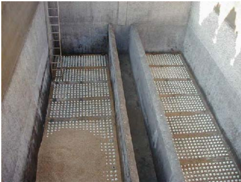
Figura A.7.6 Falso fondo formado a base de losas prefabricadas con boquillas ranuradas de plástico
