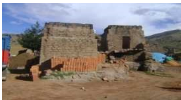
Figura 5.51. Hornos artesanales para elaboración de ladrillos
