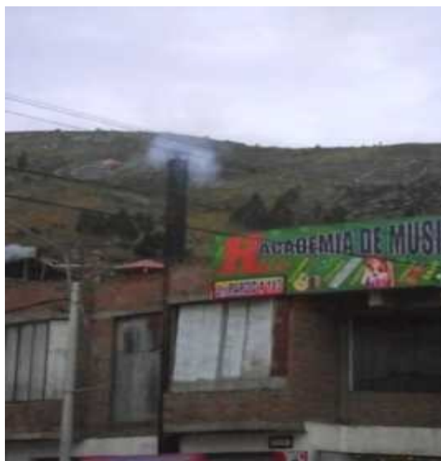
Figura 5.53. Chimenea de Pollería (Av. La Torre)
