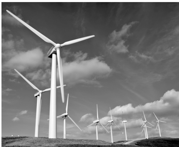
El aerogenerador eólico es una fuente alterna de energía
