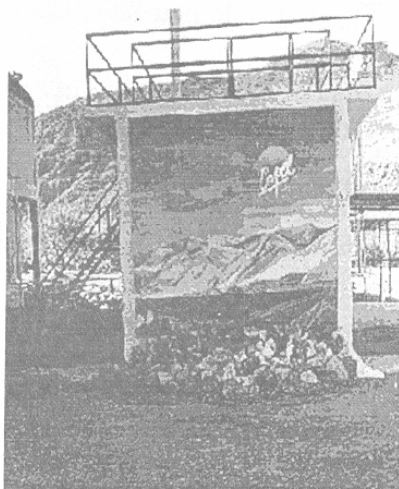
Figura 8. Vista frontal de la Planta de RILES Alto del Carmen (Reproducción autorizada por la empresa).
