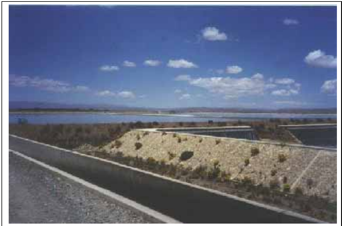
Ilustración 1: Vista de la planta depuradora de Puchuckollo
