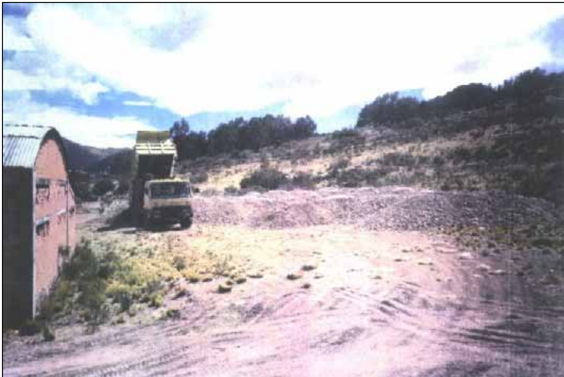
9. Acumulación de sustrato filtro para su colocación en las celdas y el posterior sembrado de totora.
