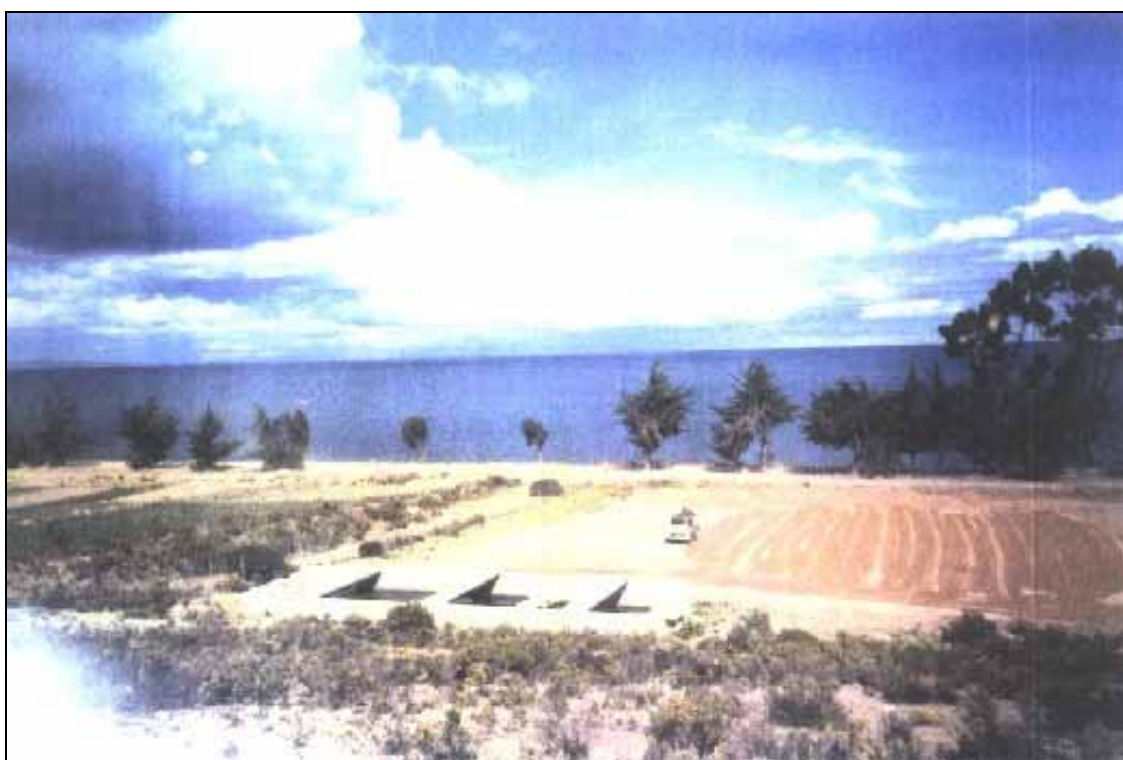
7. Aplicación de agua con tanque cisterna en todo el área del sistema de tratamiento.
