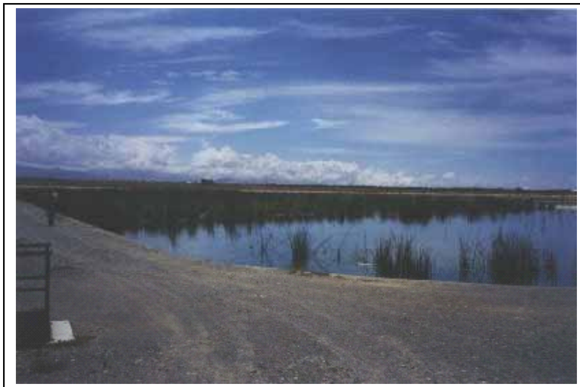
Ilustración 2: Vista de la laguna de totora en la planta depuradora de Puchuckollo
