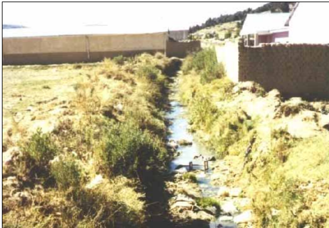
Figura 6: Zanjas construidas para colectar las aguas servidas de los domicilios. Es un sistema común en todas las poblaciones aledañas al lago.
