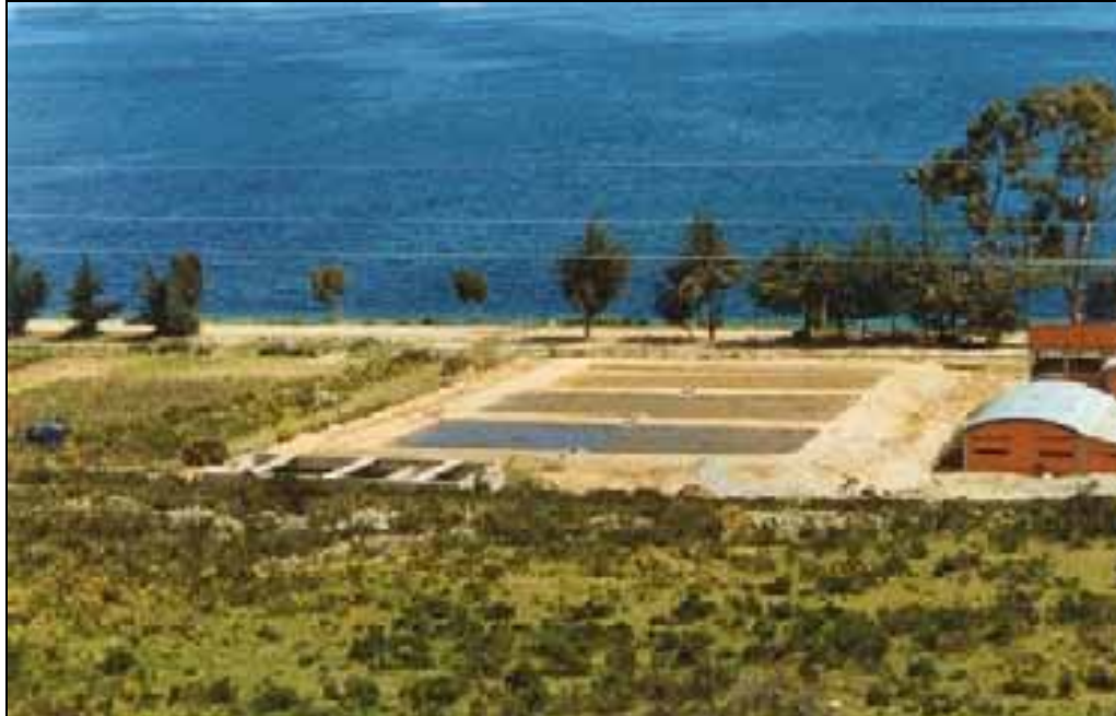
Figura 9: La planta de tratamiento en Copacabana sector Chapampa durante su construcción en agosto de 2002.
