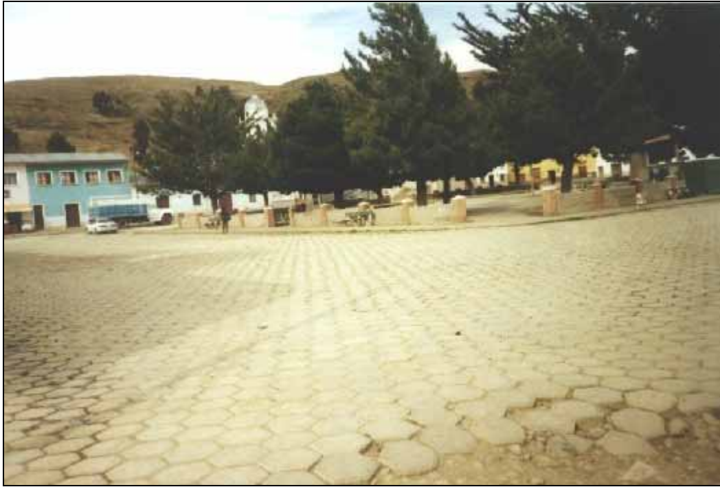
Figura 1: La plaza principal de los pueblos visitados tienen obras de infraestructura que no prevén una futura construcción de alcantarillado.
