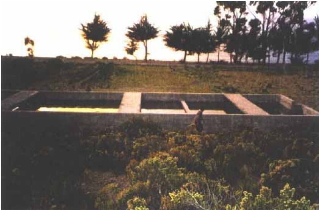
Ilustración 8: Vista fotográfica del área disponible para la planta piloto integrado al subsistema No. 1, desde el tanque de sedimentación hacia la orilla del lago Titicaca.
