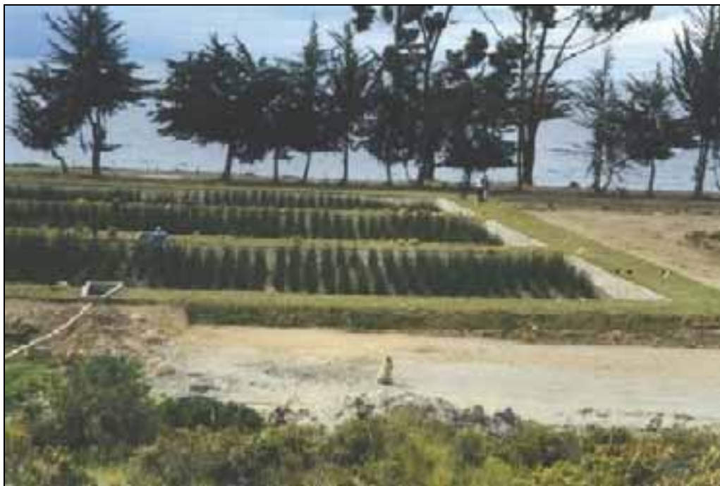
Figura 10: Visita de la planta de tratamiento justamente después la conclusión del acondicionamiento y terminación de detalles constructivos de la obra en diciembre de 2002. Algunas personas habían destruido las tuberías de conexión al sistema principal y de distribución entre las distintas celdas de purificación.
