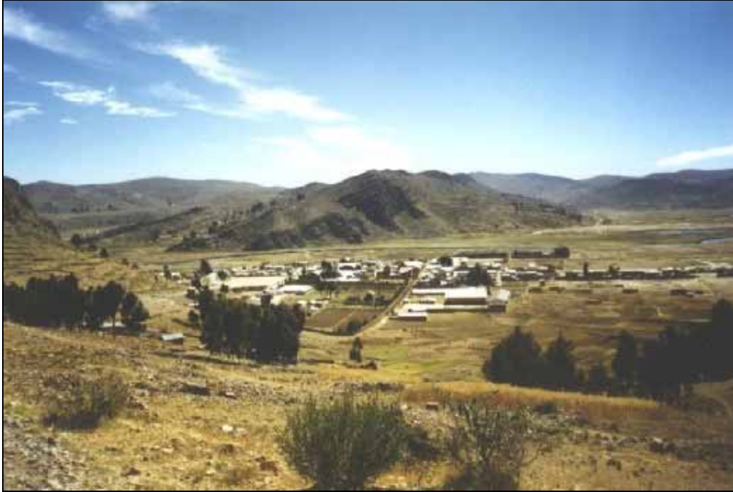
Figura 3: Vista general de una de las población aledaña al Lago Titicaca y que vierten sus aguas servidas directamente al lago.
