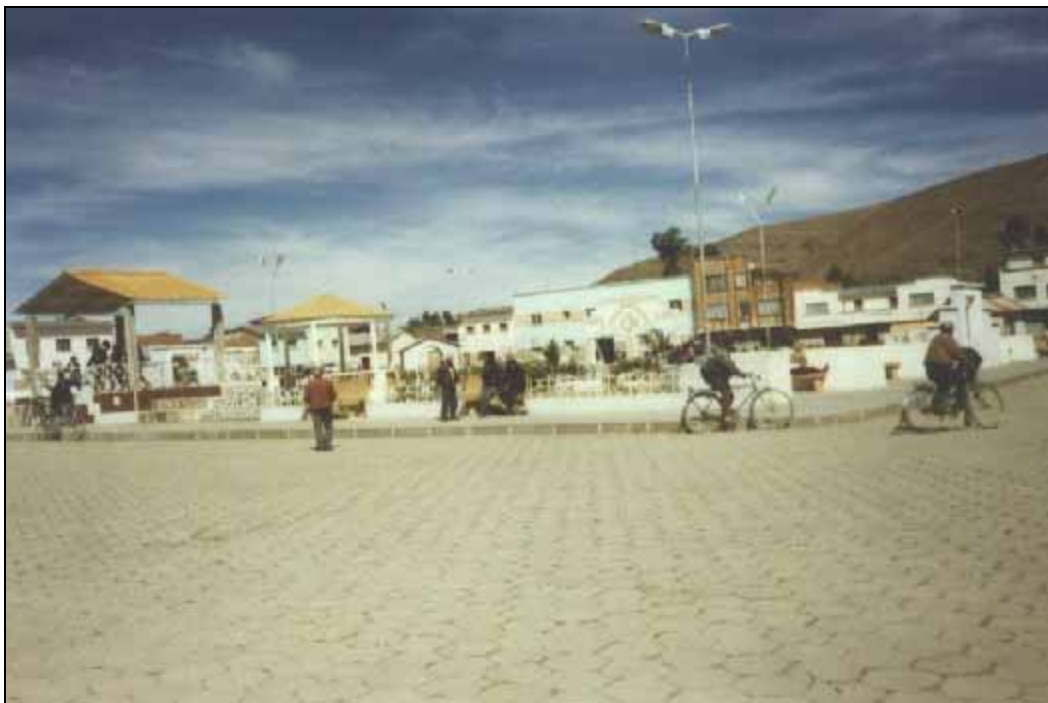
Figura 2: En los pocos pueblos que tienen un sistema de alcantarillado, éste comprende únicamente a las familias que viven alrededor de la plaza principal y su funcionamiento es totalmente deficiente.
