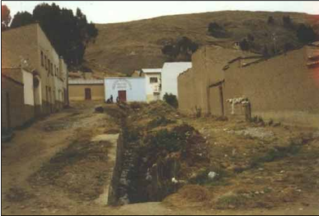
Figura 7: Las aguas servidas de los pueblos son colectadas en pequeños canales que desembocan en un cuerpo receptor que finalmente llega al lago.
