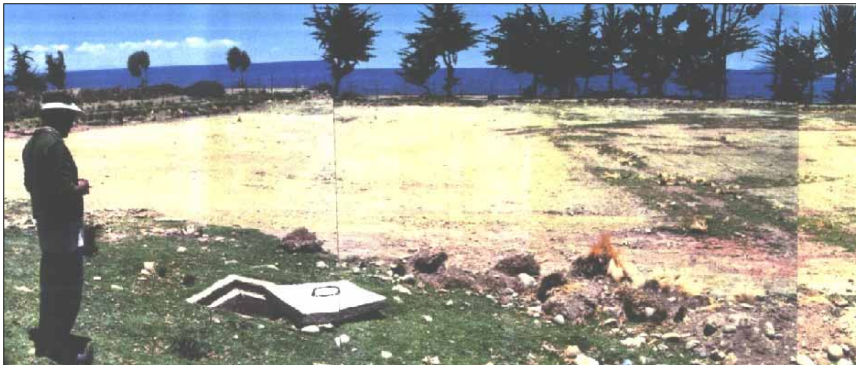
1. Obra de respaldo del área de establecimiento del sistema concluida (Gestión Alcalde Zenón Cori).
