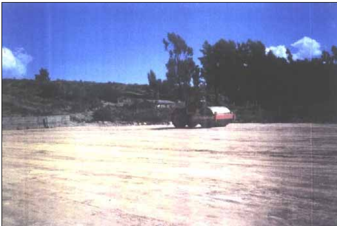
6. Compactación de la base del sistema.
