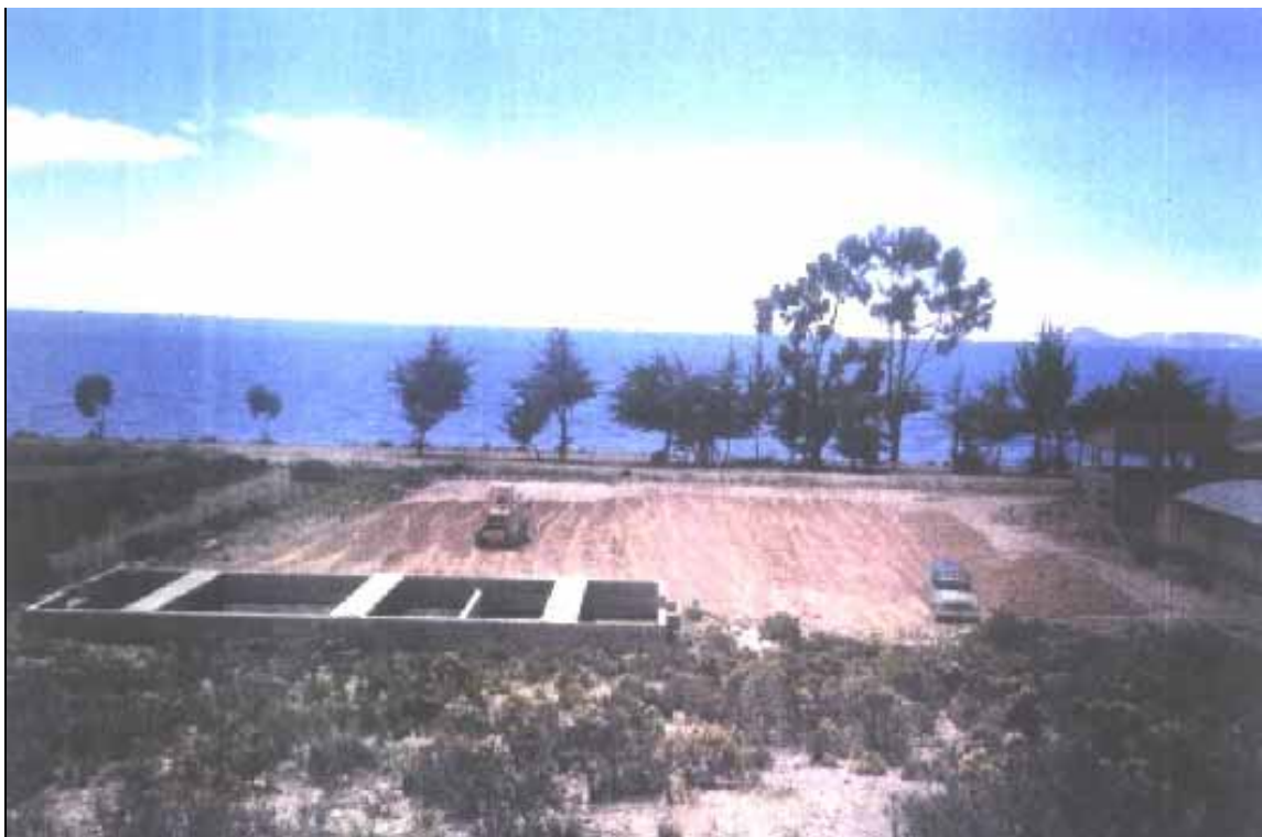
5. Distribución del material an base del sistema de tratamiento.
