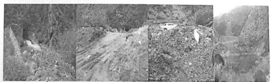
CONSTATACIÓN DE EXCEDENTES DE CONSTRUCCIÓN: Los montículos de tierra, depositados, fueron aplanados por un tractor, hasta 1:00 m. de distancia, al borde de la faja marginal (8:00 metros). Montículo de tierra posiblemente extraído de una zona de suelo agrícola; tiene pastura natural y arbustos, contiene su textura, tierra de color negro, marrón, rojo y gris, con materia orgánica y raíces.
