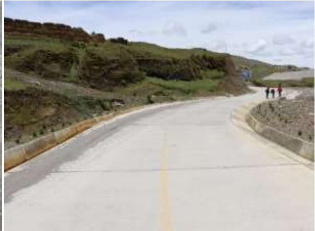
Nota: El tramo presenta un sector en donde la superficie de rodadura es de Pavimento rígido.
