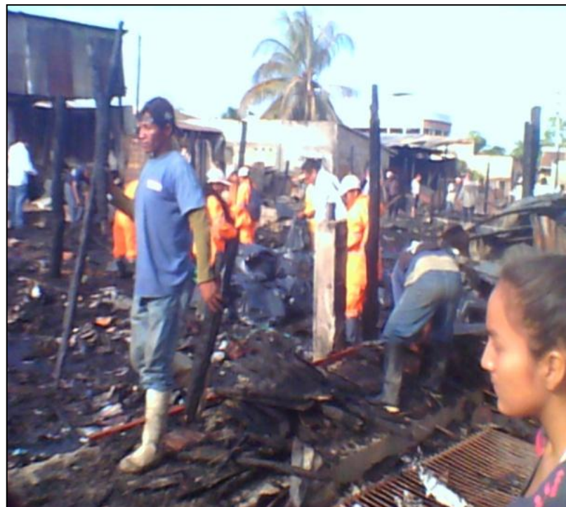
TRABAJOS DE LIMPIEZA Y REMOCIÓN DE ESCOMBROS
