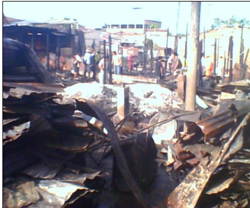
DAÑOS OCASIONADOS A CONSECUENCIA DEL INCENDIO EN EL AA.HH. LAS AMAZONAS
