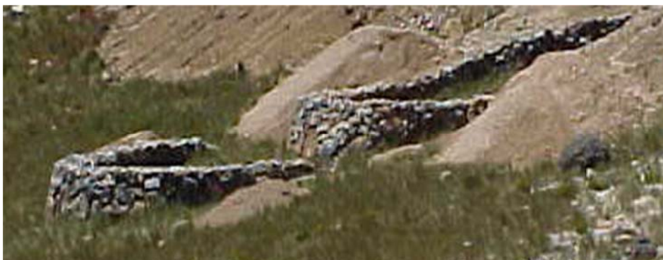
Barrera de piedras o pircas
