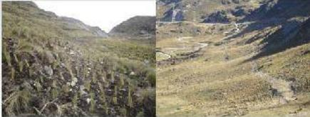
Foto N° 64: Acceso a plataformas N° 11 y 13, aperturado y cerrado y revegetado con Ichu y Ray Grass
