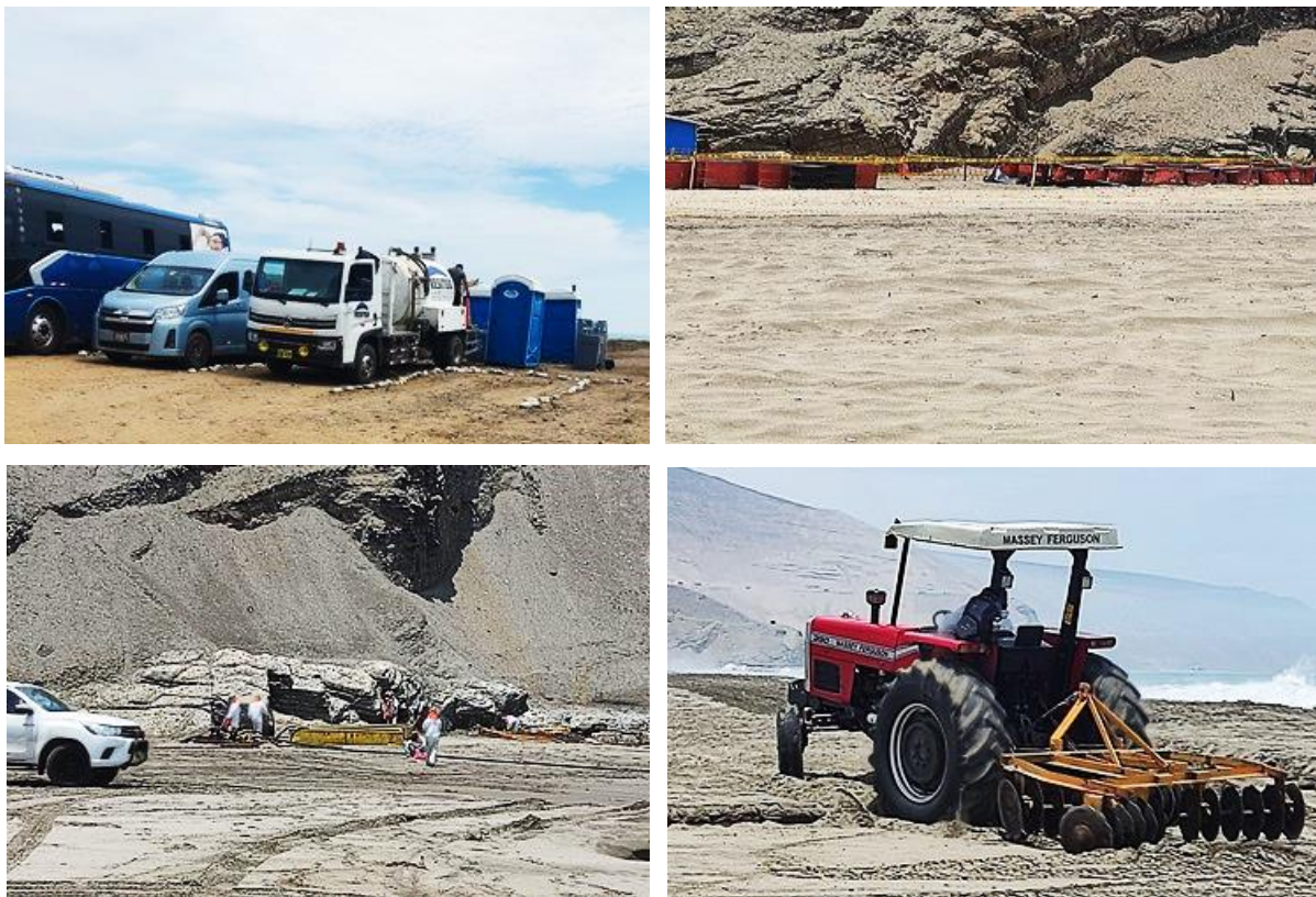
Figura 6.- Trabajos de remediación: Transporte, cilindros con residuos oleoso, maquinarias y arado. Playa Chacra y Mar, distrito Aucallama, provincia Huaral, Región Lima. 04.03.2022
