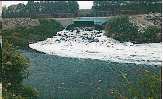
Foto N° 04: Río Lurín vertimiento de aguas residuales de la PTAR San Bartolo.
