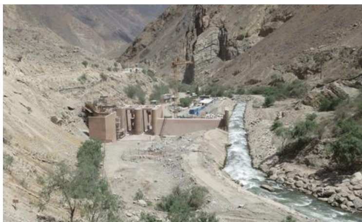
Bocatoma del Proyecto Cheves en Construcción
