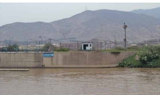
Foto N° 18: RRima-11, Bocatoma N° 2, Planta de tratamiento de agua potable La Atarjea
