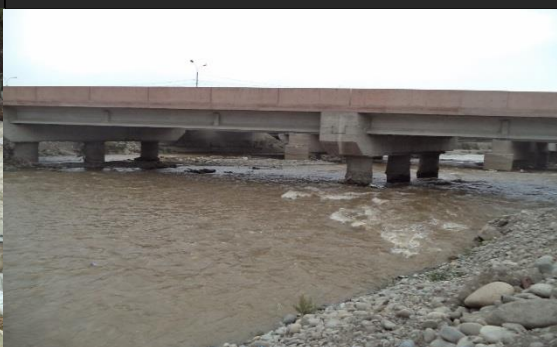
Foto N° 20: RRima-13, 20 m. aguas arriba del puente Néstor Gambeta, en Av. Néstor Gambeta
