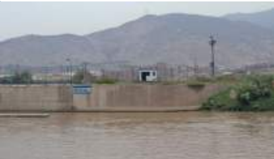
Foto N° 18: RRima-11, Bocatoma N° 2, Planta de tratamiento de agua potable La Atarjea
