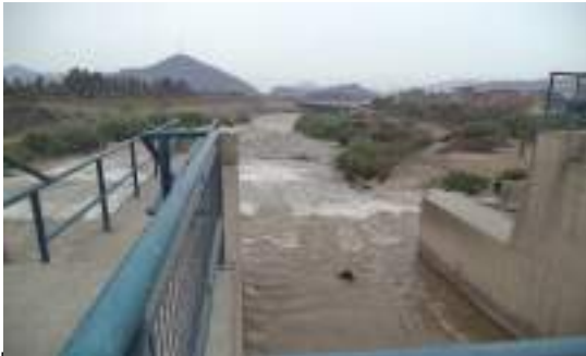
Foto N° 17: RRima-10, Bocatoma N° 1, Planta de tratamiento de agua potable La Atarjea
