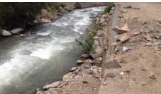
Foto N° 10: RRima-7, 100 m. aguas arriba del puente Ricardo Palma, altura km. 38 Carretera Central
