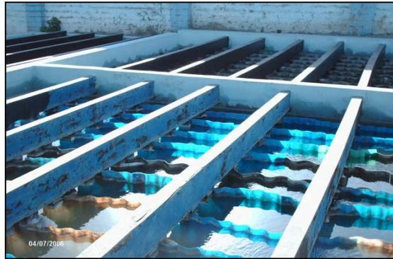
El segundo de ellos tiene una longitud de 193,56 m, consta de dos partes, la primera que tiene una longitud de 132,00 m y una separación promedio entre baffles de 0,28 m, y la segunda que tiene una longitud de 61,56 m y una separación promedio entre baffles de 0,46 m; ambas con alturas de agua variables pero con un promedio de 1,95 m y 0,21 m de borde libre.
