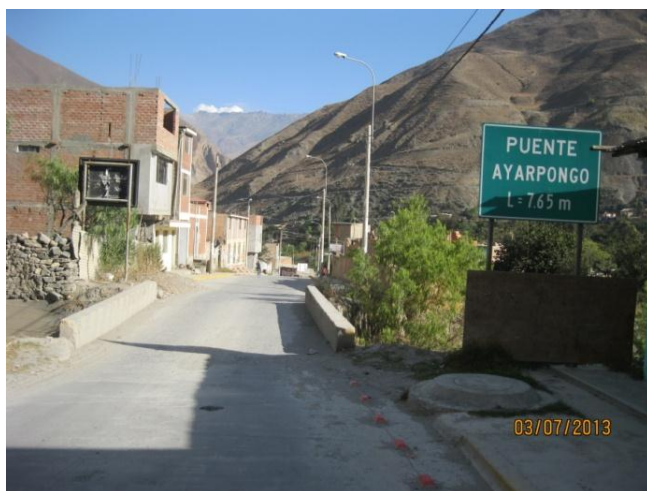
Vista de las limitaciones para desvío de tránsito, se requiere ocupar propiedad privada con demoliciones de muros que habría que reponer. El espacio es restringido para maniobras de tránsito pesado.
