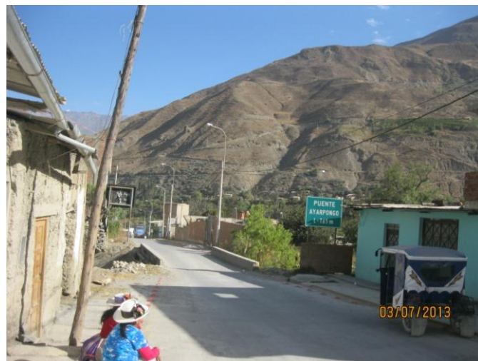
Puente Ayarpongo, visto con rumbo hacia Churín
