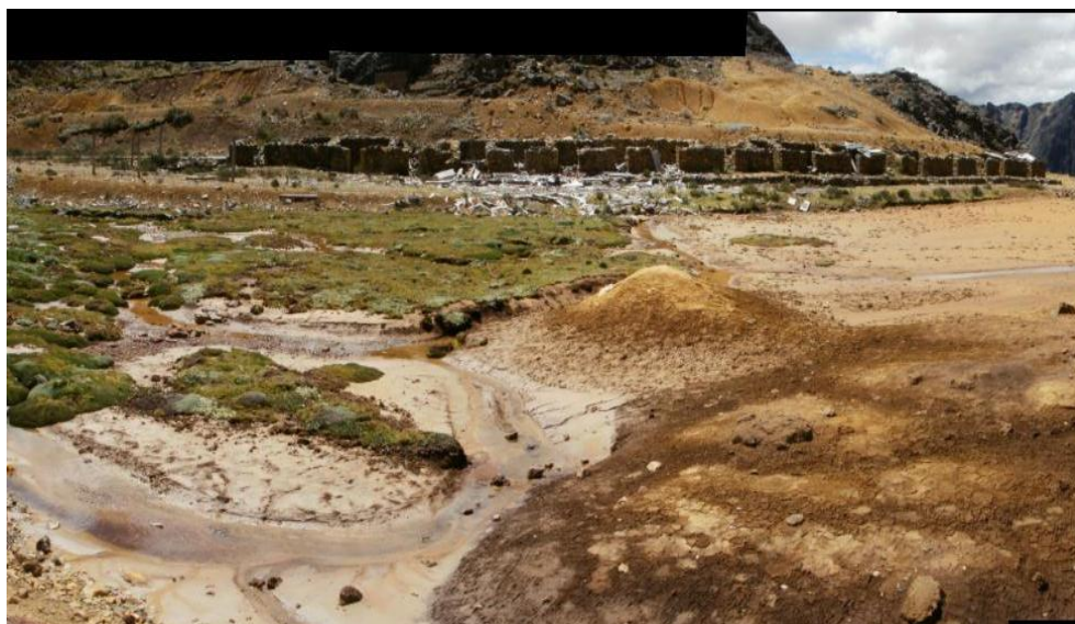
Vista panorámica de estructura del campamento abandonado y zona aparentemente desbrozada y aparentemente nivelada, probablemente con presencia de metales.
