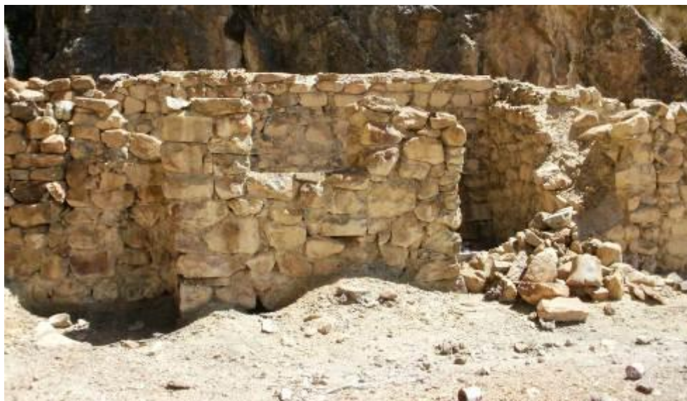
Muros en Zona Campamento.
