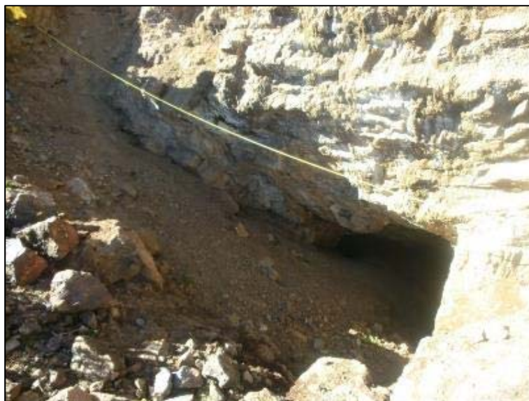
Fotografía N° 4.2 Vista de la bocamina abandonada
