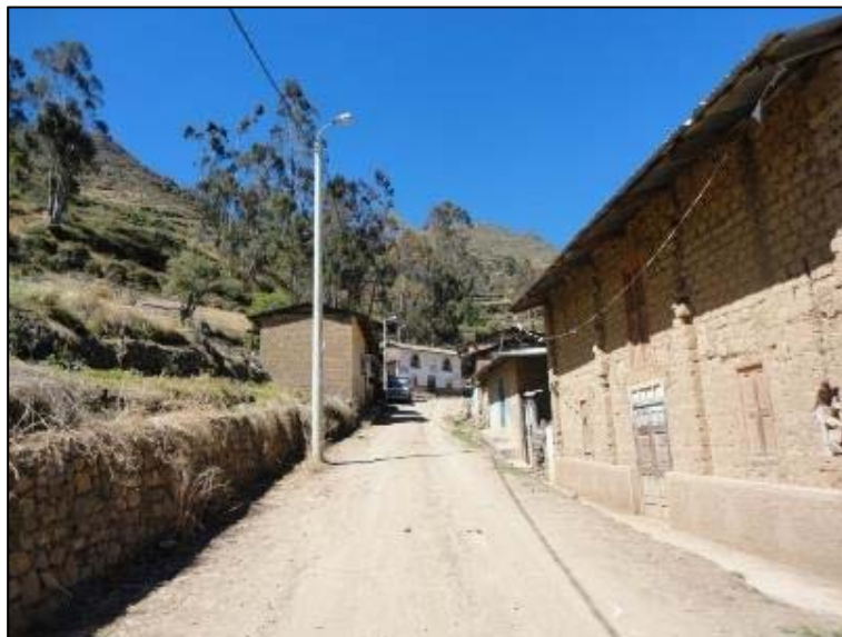
Fotografía N° 4.56 Servicio de Alumbrado Eléctrico
