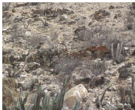
Fotografía Nro. 17: detalle de muros de contención de origen arqueológico, reconstruidas y reutilizadas en el sitio arqueológico 1-Sector A.
