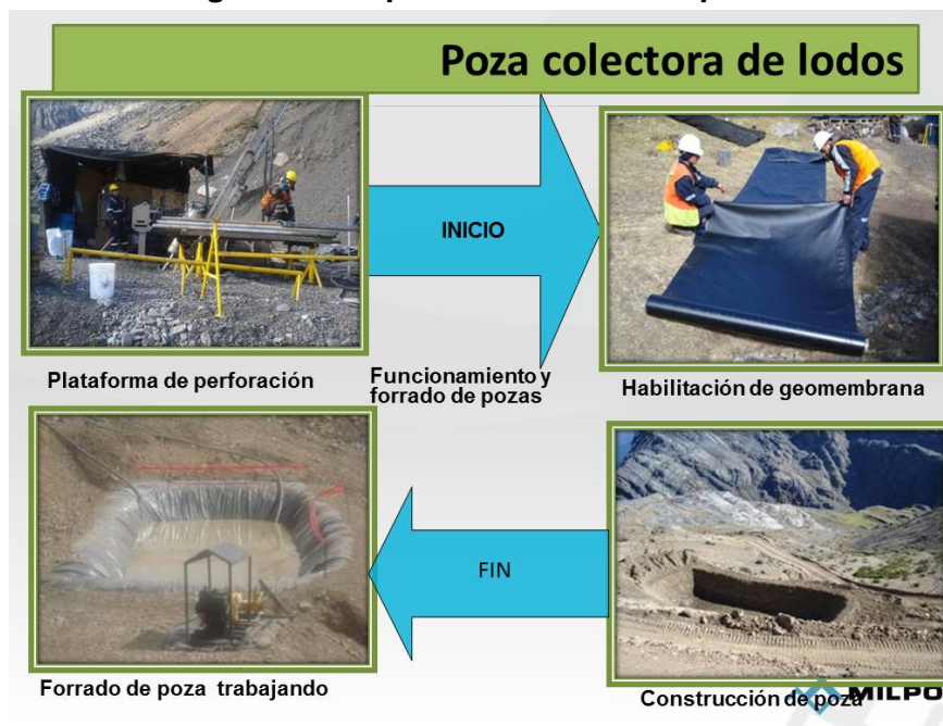
Figura 5.2: Impermeabilización de pozas
