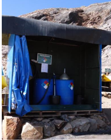
Foto 5.2: Almacén de combustible para plataforma, operación diaria
