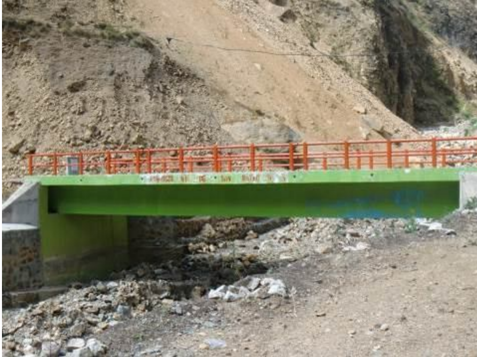
Foto 19 Puente Carrozable hacia la comunidad de Viso
