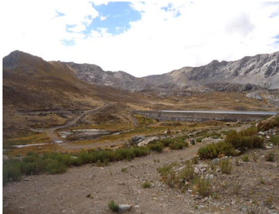
Foto 2.3 Acceso construido a represa
