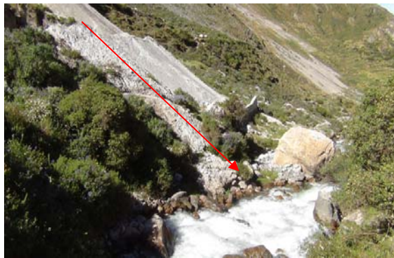
Ilustración 10. Deslizamiento de las escombrerías hacia el cauce en la mina de cal de Santa cruz de Andamarca.
