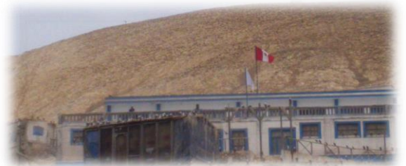
Oficinas Reserva Nacional Sistema de Islas, Islotes y Puntas Guaneras
