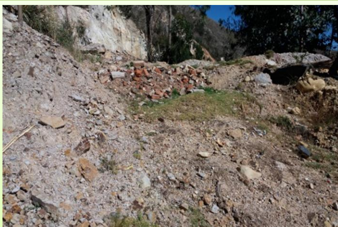
Sánchez Carrión.- (Carretera Marca Huamachuco) Residuos sólidos de construcción y demolición.
