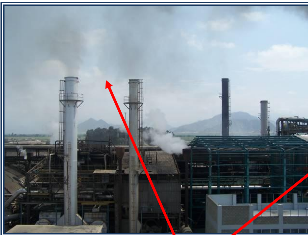
Calderas con mantenimiento insuficiente
