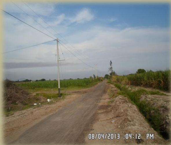
La obra se encuentra en etapa de culminación, falta la instalación por parte de Hidrandina para el funcionamiento. Las instalaciones de los postes y excavaciones fueron realizadas de manera artesanal ocasionando un mínimo impacto.
