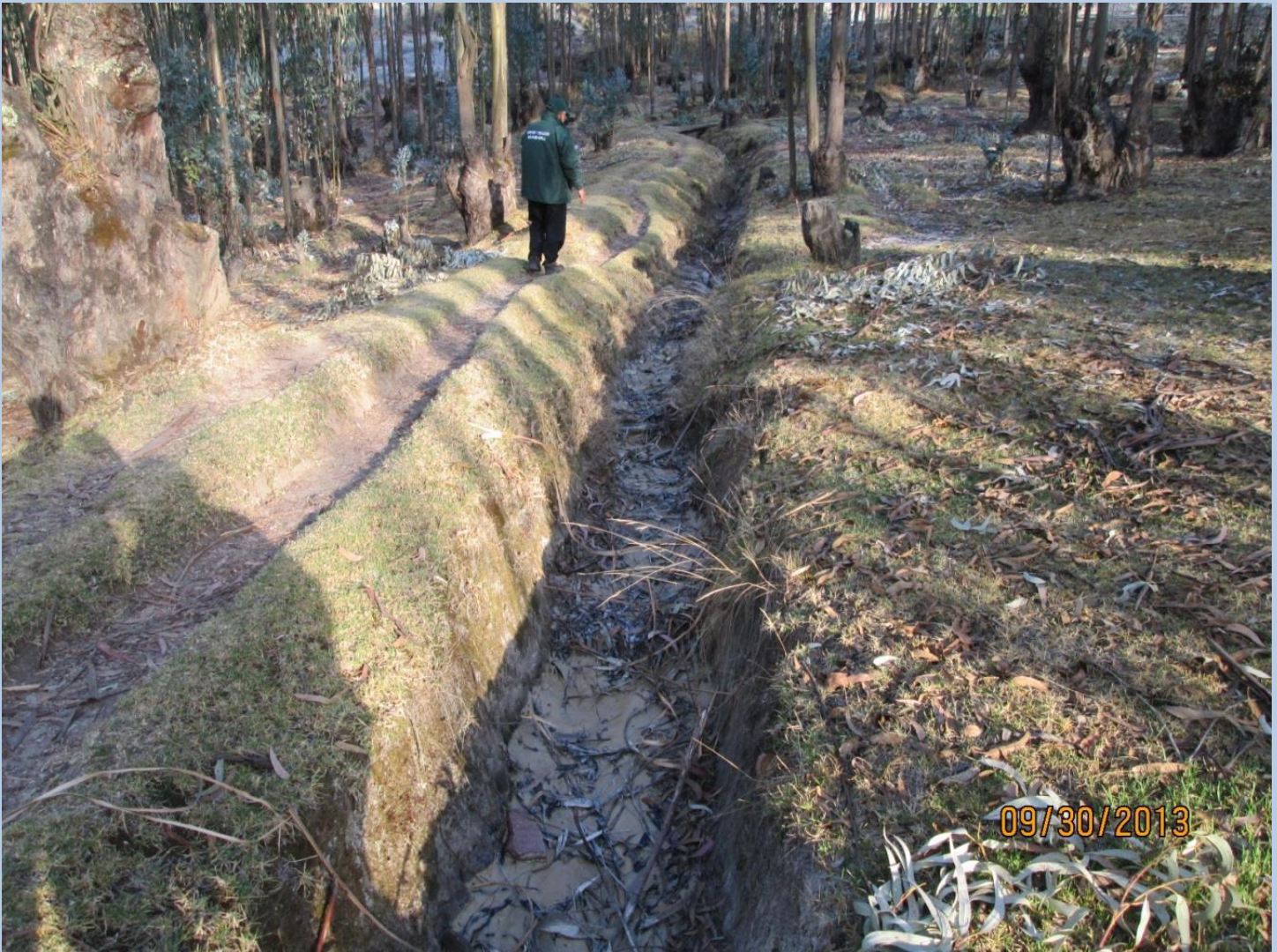
Canal que ha recibido los relaves provenientes de la parte alta
