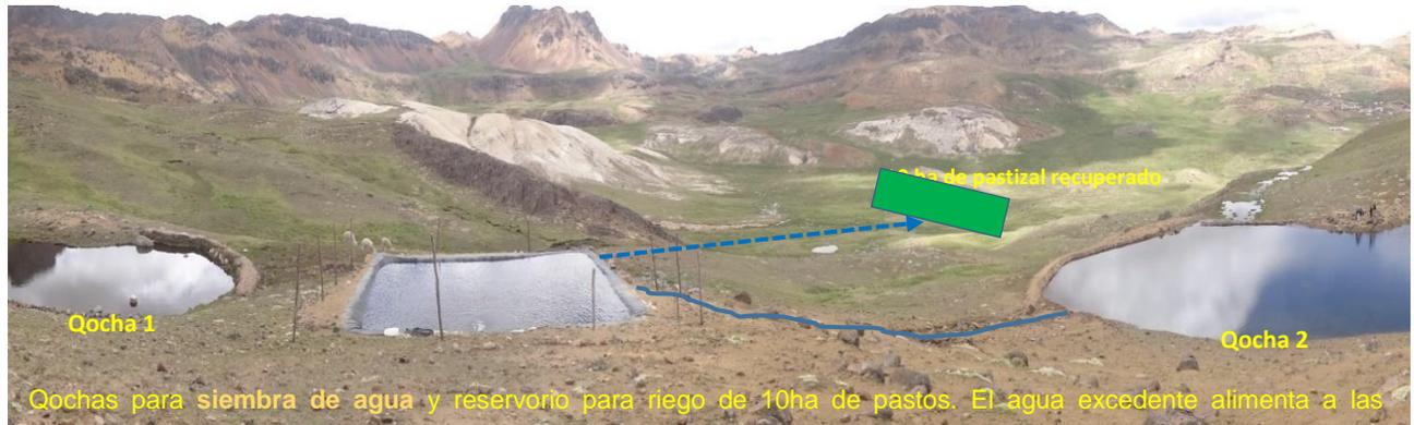
**Foto N° 10.** Reservorio que suministra agua para riego por aspersión a 10ha de pastizales con algunas porciones de humedal. A los costados del reservorio, 2 qochas con diques para retener y almacenar agua de lluvia e inducir la recarga hídrica in situ y cuenca abajo.
