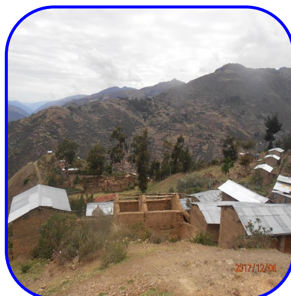
REGISTRO N° 04: Viviendas rurales dentro de la comunidad. Predomina material de adobe.
