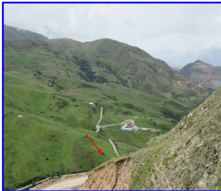
Fotografía N° 06.- Deslizamiento de material
