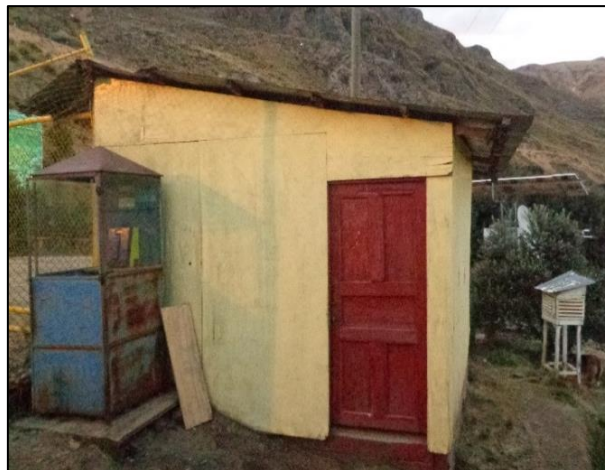
Fotografía N° II - 56: Ex Casa de Lámparas
