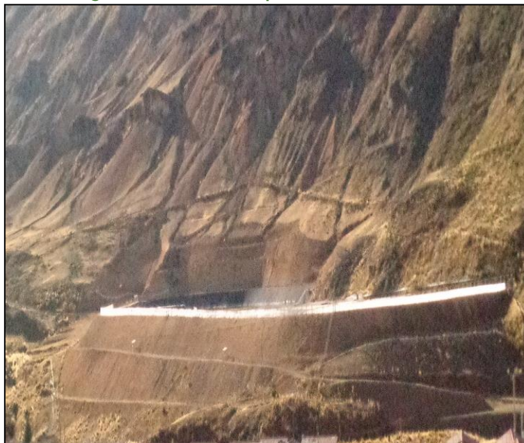
Fotografía N° II - 47: Depósito de Relaves N° 3 - 4
