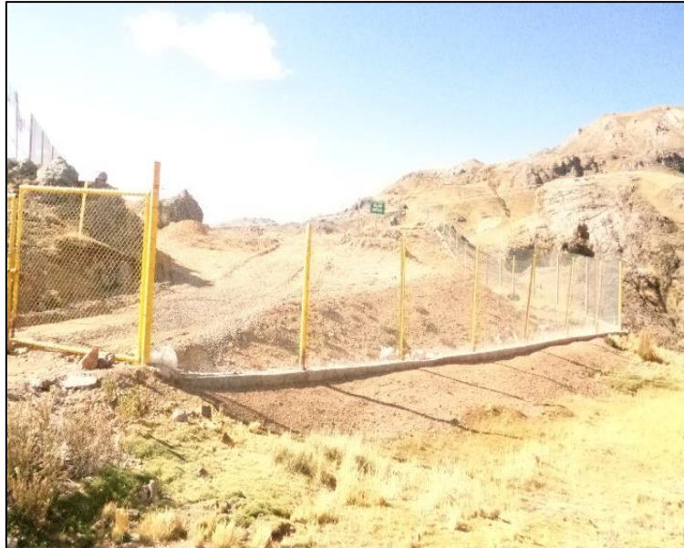
Fotografía N° II - 60: Relleno Sanitario (INF-RE-08)
