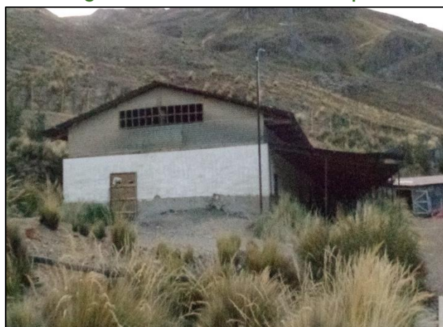
Fotografía N° II - 54: Taller de Carpintería
