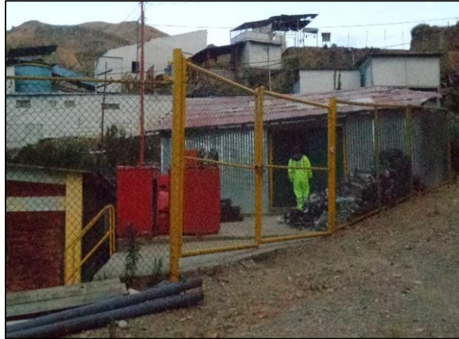
Fotografía N° II - 55: Almacén de Taller Eléctrico
