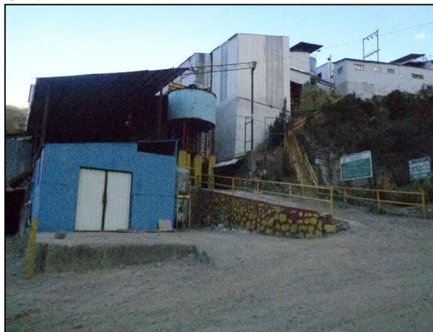
Fotografía N° II - 43: Planta Concentradora PL-RE-01
