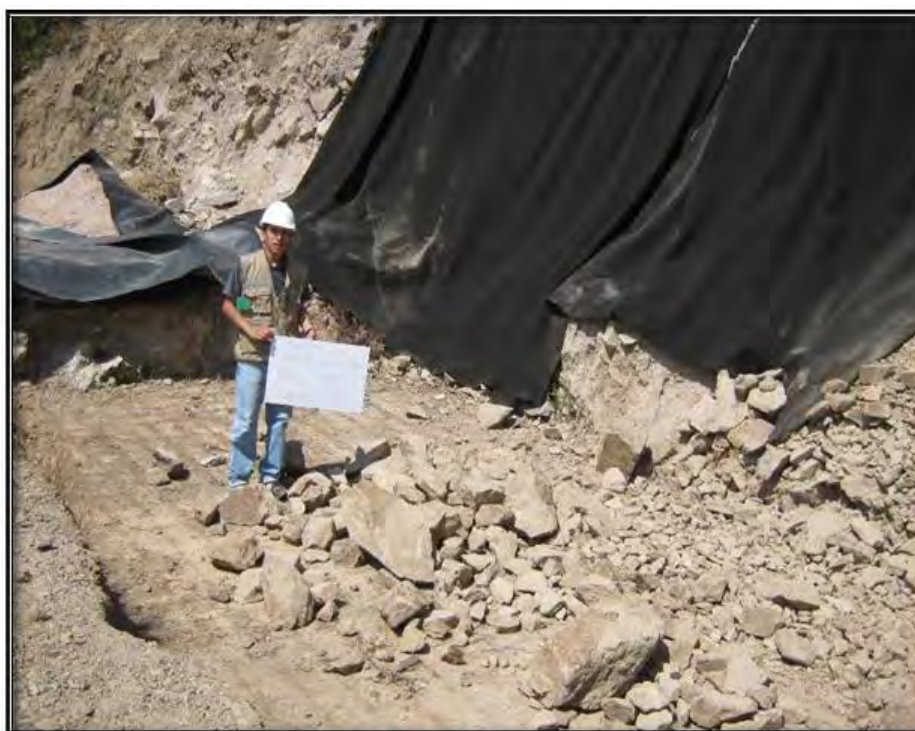
Figura 3-5: Vista actual de Poza de Sedimentación
