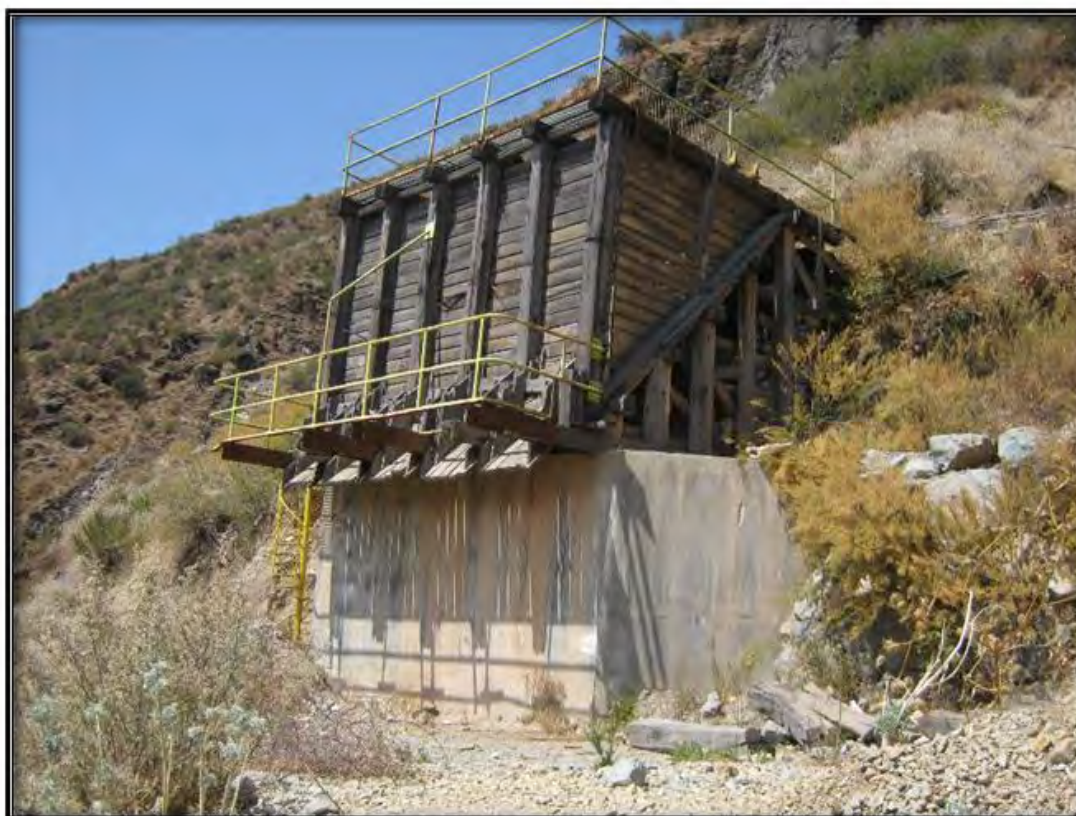
Figura 3-6: Vista actual de Tolva de mineral y desmonte (TOL-01)
