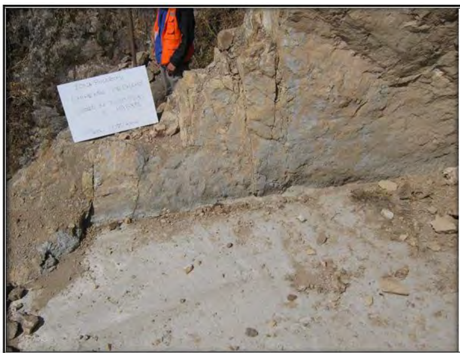
Figura 3-4: Vista actual de Chimenea CHP-625
