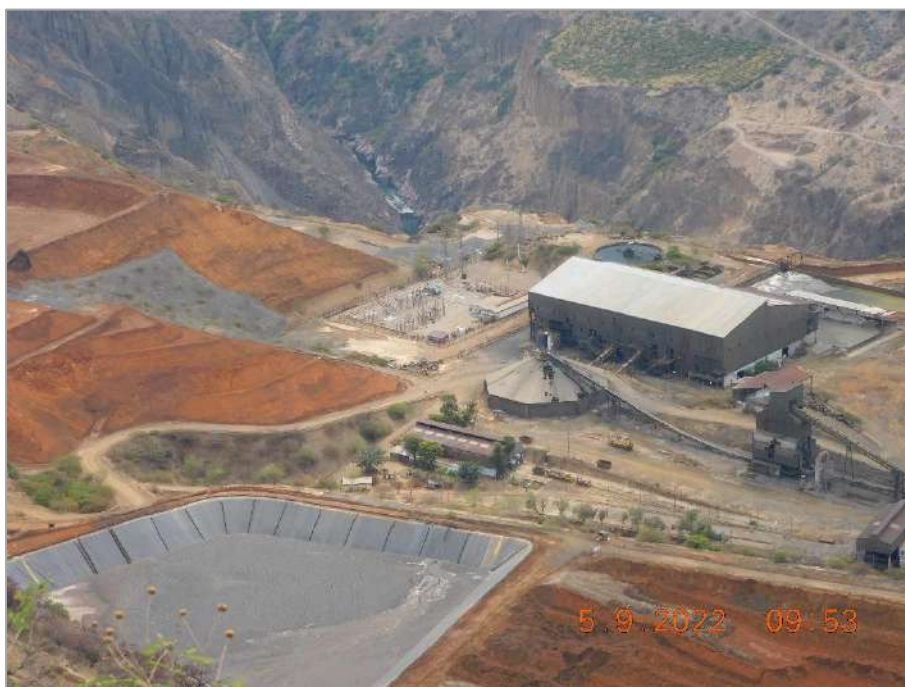
Fotografía 5: AIP Shaqsha 2 (subestación eléctrica Cobriza 2), se ubica dentro de la unidad minera Cobriza de la empresa Doe Run, no registrándose poblaciones en su entorno inmediato o a menos de 200 metros del área de influencia.
