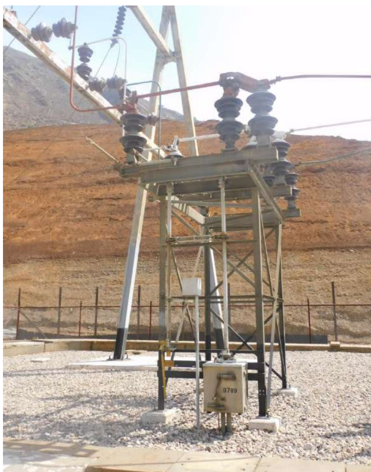
Fotografía 4-2 Seccionador de línea de 72.5 kV
