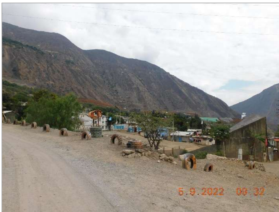
Fotografía 7: Anexo Expansión, se puede observar que el acceso al poblado es mediante una vía sin afirmar, de estado regular y con un ancho aproximado de 5 metros, la cual se conecta con la vía provincial Emp. PE-3S (Chonta), San Pedro de Coris-Dv. Cobriza.
