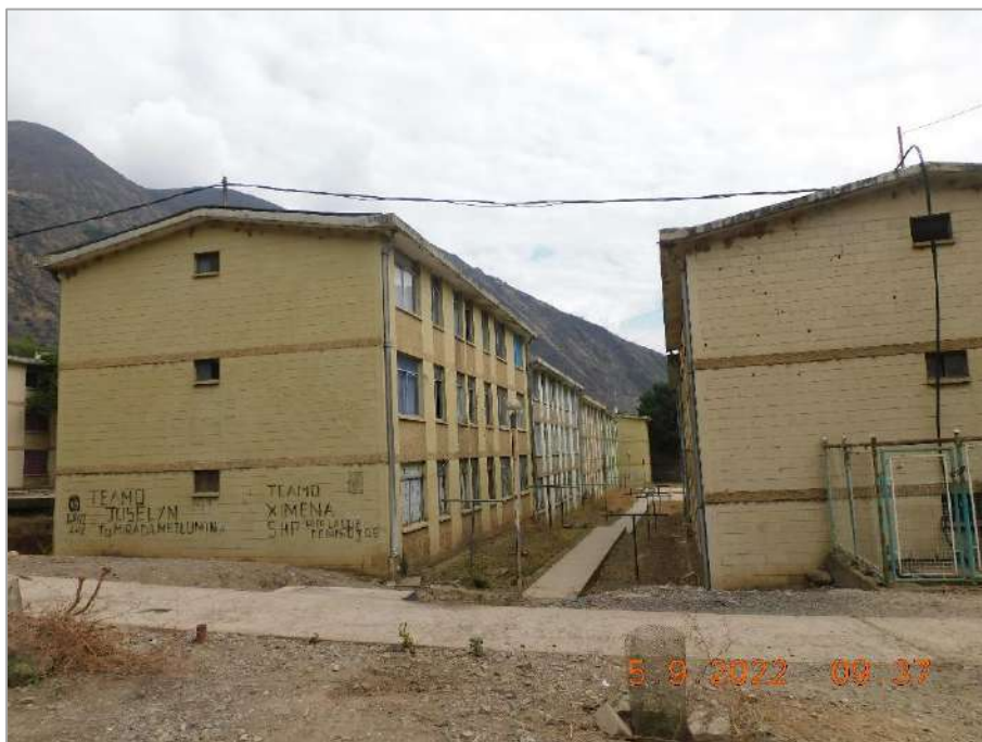
Fotografía 10: Anexo Expansión, se puede identificar el campamento minero de trabajadores Cobriza de la empresa Doe Run.
