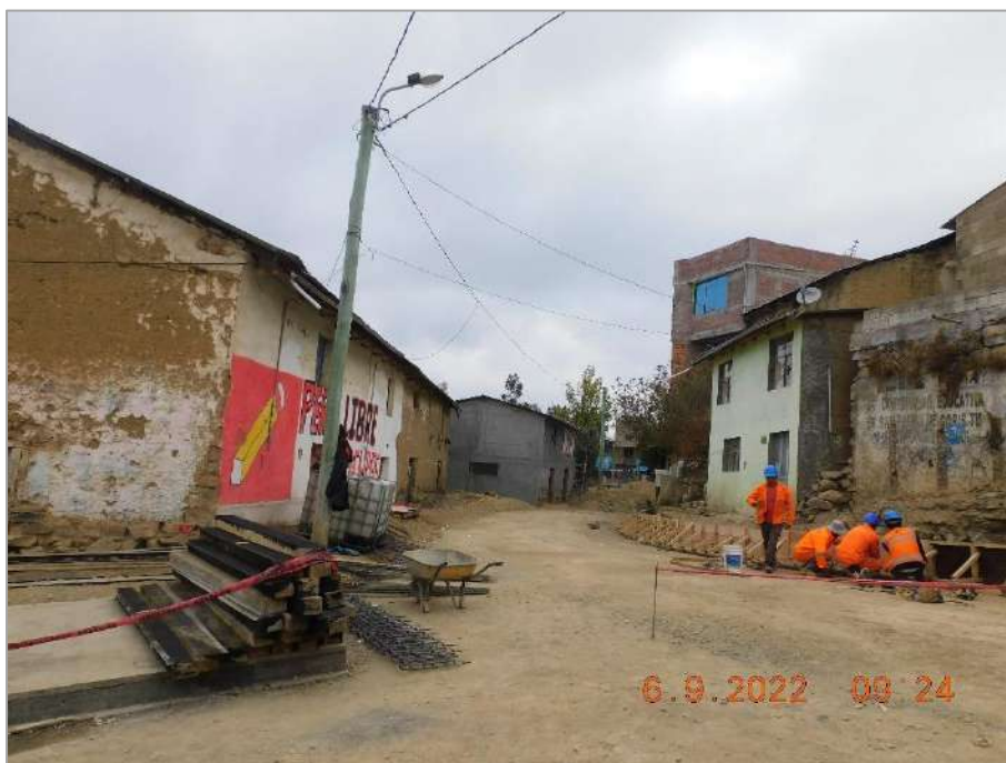
Fotografía 36: Distrito San Pedro de Coris, se observó que algunas calles no se encuentran pavimentadas; sin embargo, también se apreció que se vienen desarrollando obras de pavimentación en las mismas.
