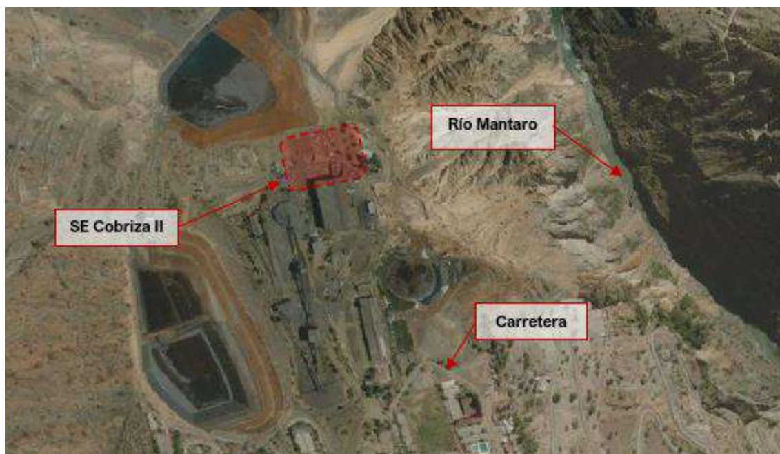
Figura 5-2 Ubicación local del componente – Subestación eléctrica Cobriza II
