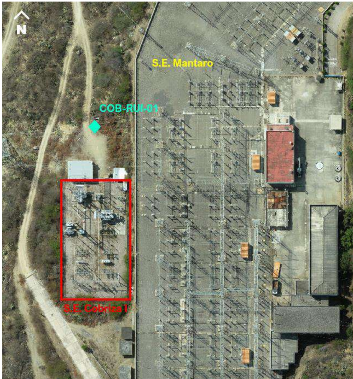
Figura 9.2-3 Estación de monitoreo de niveles de ruido ambiental – SET Cobriza I
