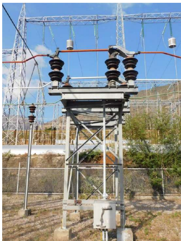
Fotografía 4-4 Seccionador de barra en 72.5 kV
