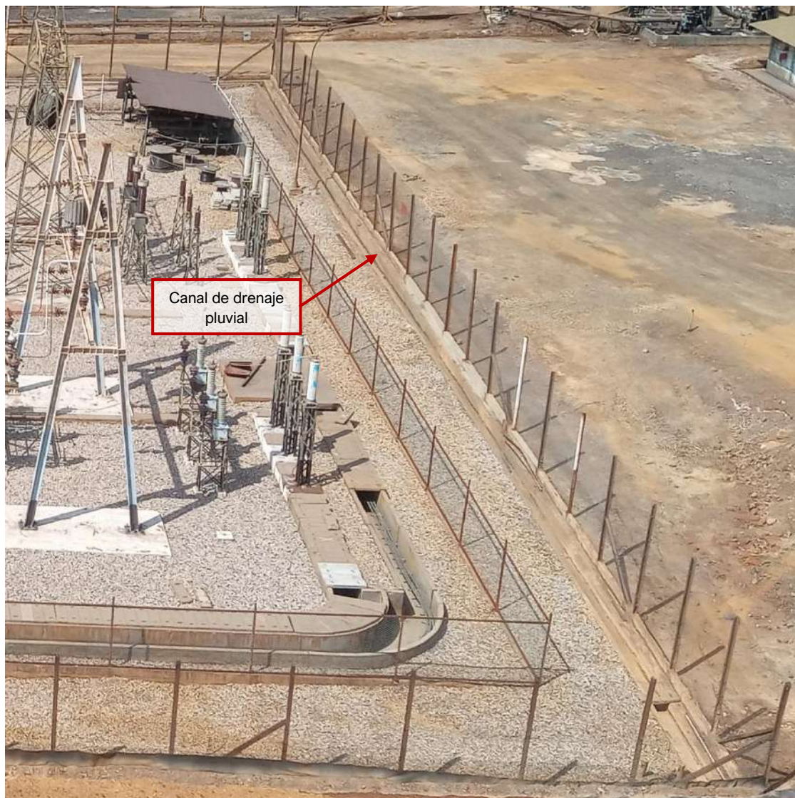
Fotografía 3.3-30 Vista de canal de drenaje pluvial abierto
