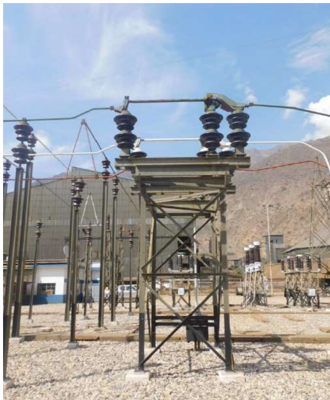
Fotografía 4-4 Seccionador de barra en 72.5 kV
