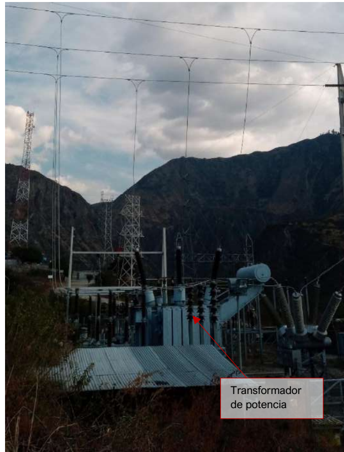
Fotografía 3.3-1 Vista actual 1 del componente
