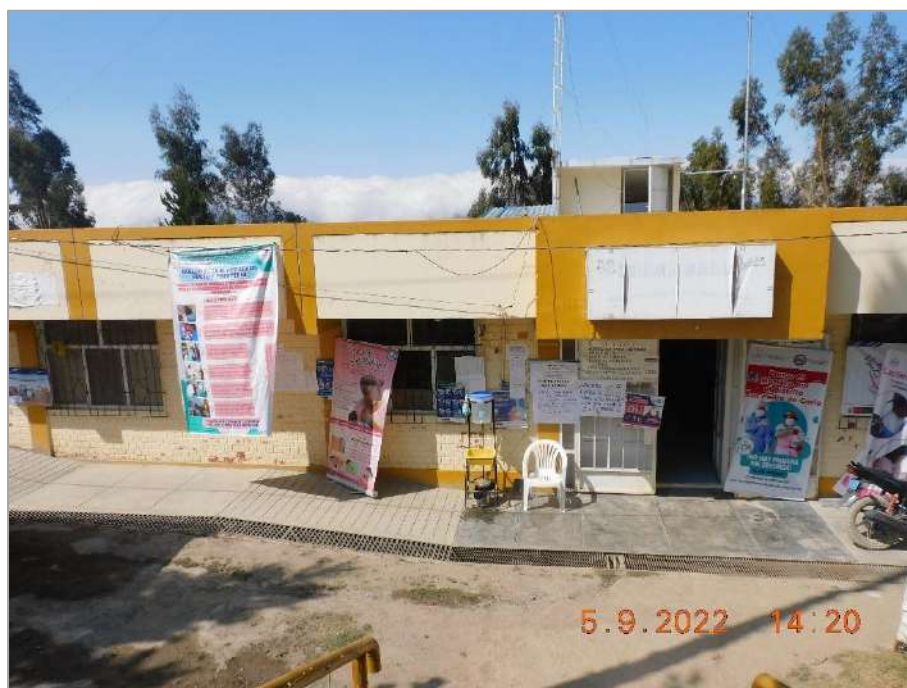
Fotografía 33: Centro de Salud San Pedro de Coris, ubicado en el distrito del mismo nombre.
