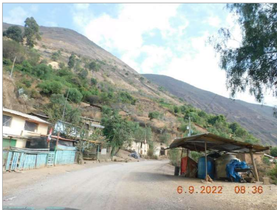
Fotografía 16: Localidad Machahuay (zona baja), se pudo observar otro tramo del principal acceso a la localidad, esta es, la vía departamental Emp. PE-3S D (Chonta), San Pedro de Coris-Dv. Cobriza, el cual presenta una superficie afirmada con material granular natural.
