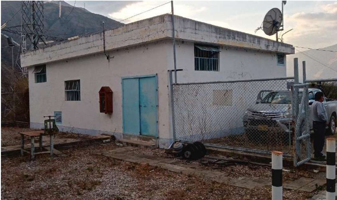
Fotografía 3.3-10 Vista exterior de Sala de Control
