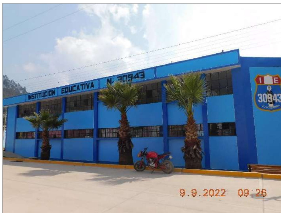
Fotografía 27: IE 30943, anteriormente fiscalizado de varones, ubicado en el distrito de Colcabamba.
