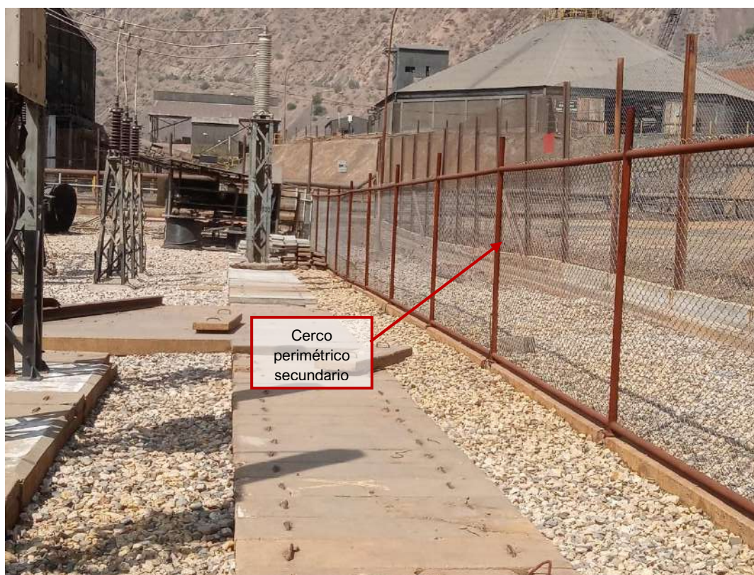
Fotografía 3.3-38 Vista de Cerco perimétrico secundario
