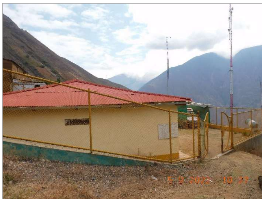
Fotografía 17: Puesto de Salud Cobriza-Machahuay, ubicado en la localidad Machahuay.
