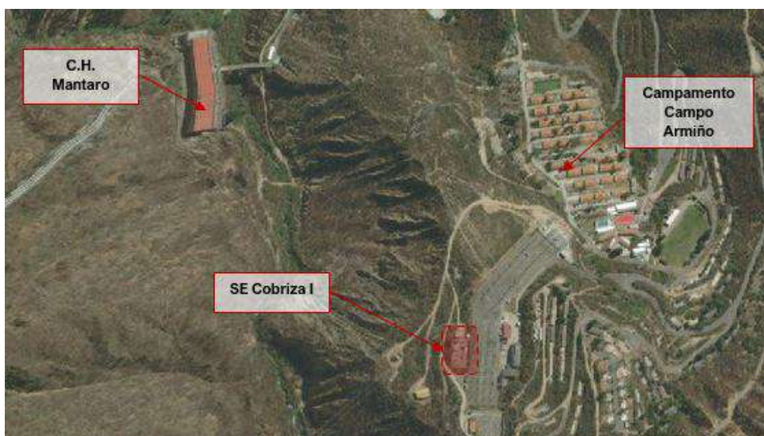
Figura 5-1 Ubicación local del componente – Subestación eléctrica Cobriza I
