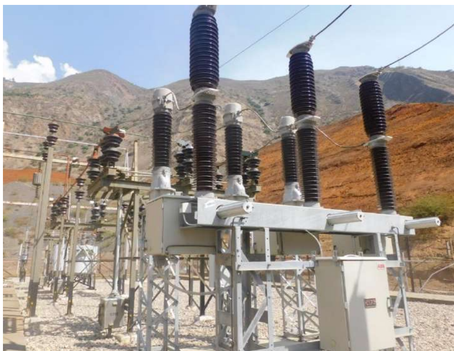
Fotografía 4-6 Interruptor de potencia en SF6 en 72.5 kV
