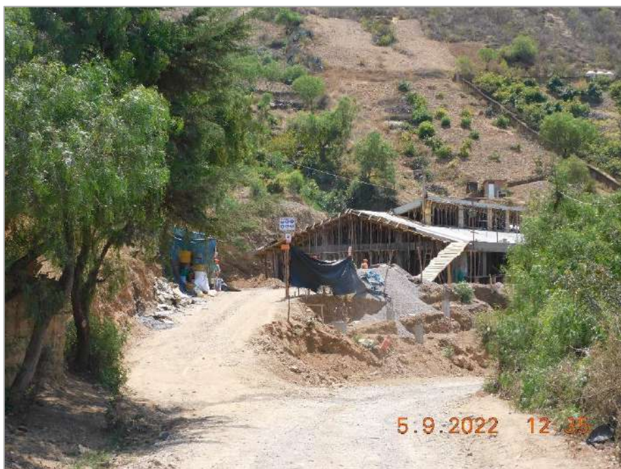
Fotografía 18: Construcción de un nuevo establecimiento de salud como parte de la obra “Mejoramiento de los servicios de salud del primer nivel de atención del Puesto de Salud Cobriza (Machahuay) de la microrred de Paucarbamba, red de Churcampa, distrito de San Pedro de Coris, provincia Churcampa, región Huancavelica”.
