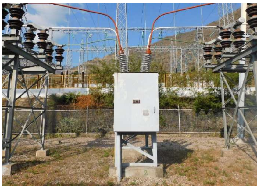
Fotografía 4-2 Interruptor de potencia de 72.5 kV
