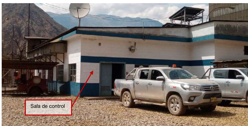
Fotografía 3.3-28 Vista Exterior de Sala de Control
