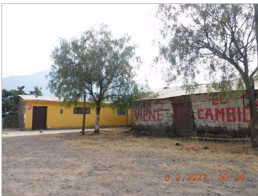
Fotografía 15: Localidad Machahuay (zona baja), se pudieron apreciar viviendas cuyo material de construcción predominante es la tapia.
