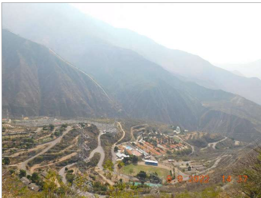
Fotografía 1: Vista general del AIP Shaqsha 1, ubicado dentro de las zonas de operaciones del Complejo Hidroeléctrico Mantaro, siendo su entorno cercano la planta de la Subestación Eléctrica Mantaro y un campamento de trabajadores del complejo eléctrico denominado Campo Armiño.
