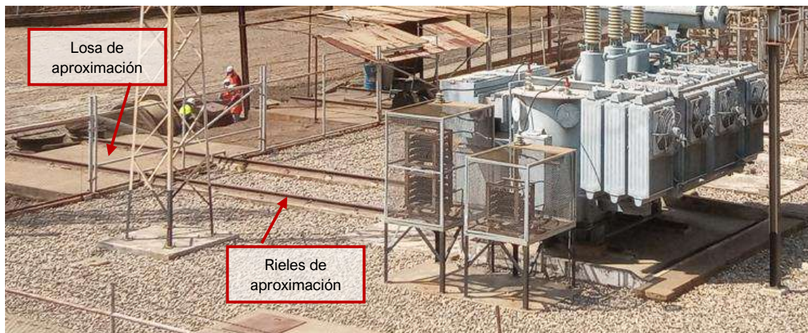
Fotografía 3.3-22 Vista de Rieles de aproximación
