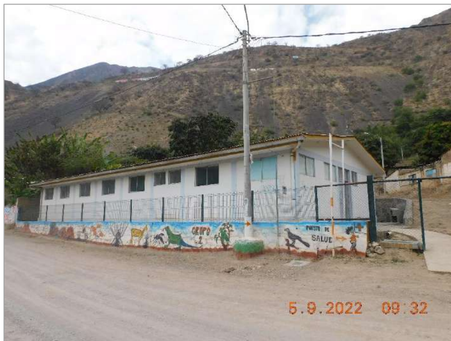
Fotografía 9: Puesto de Salud Satélite, ubicado en el Anexo Expansión, donde el personal médico del Puesto de Salud de Machahuay-Cobriza (ubicado en la localidad Machahuay) visita y atiende dos a tres veces por semana a la población de Expansión.
