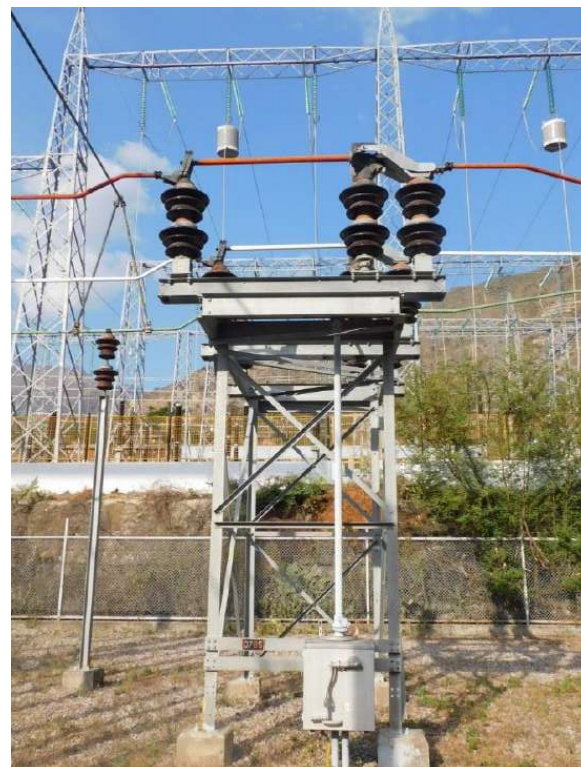
Fotografía 4-4 Seccionador de barra en 72.5 kV
