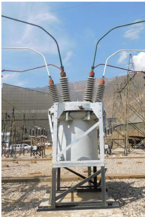
Fotografía 4-6 Interruptor de potencia en SF6 en 72.5 kV
