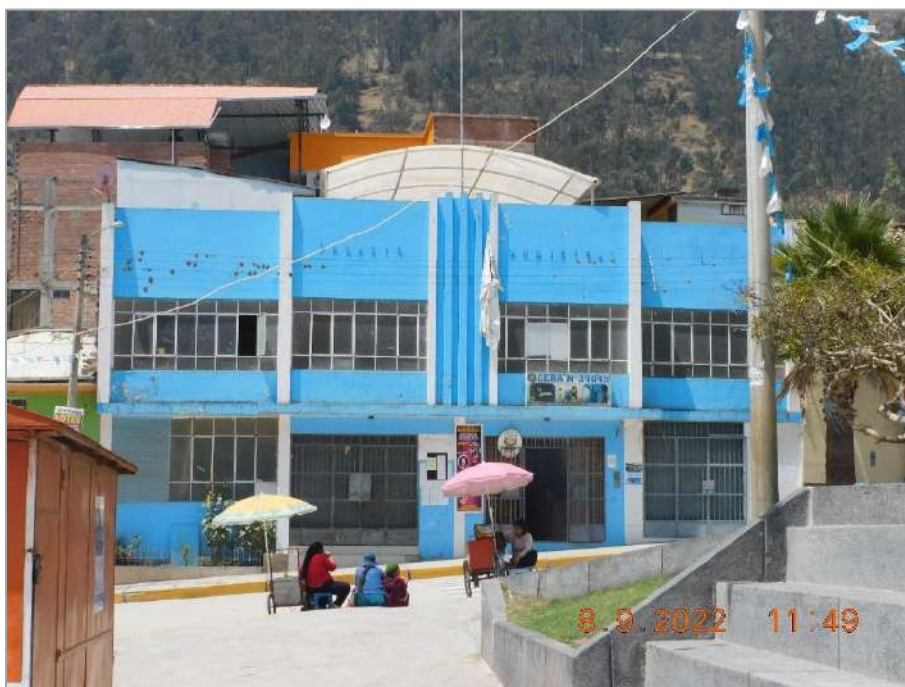
Fotografía 28: CEBA 34045 del distrito de Colcabamba, ubicado en las anteriores instalaciones del Palacio Municipal.
