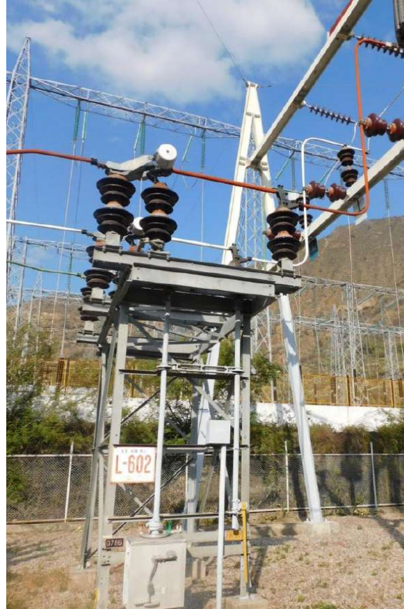
Fotografía 4-4 Seccionador de barra en 72.5 kV
