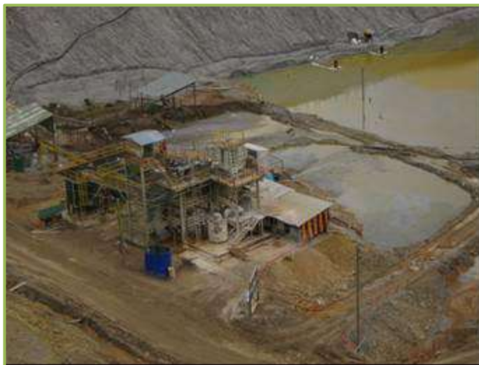
Figura 5-4: Panorámica de la planta de tratamiento NCD y la cancha C
