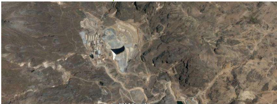
Foto 4-5: Vista de la Zona 5 de Operaciones
