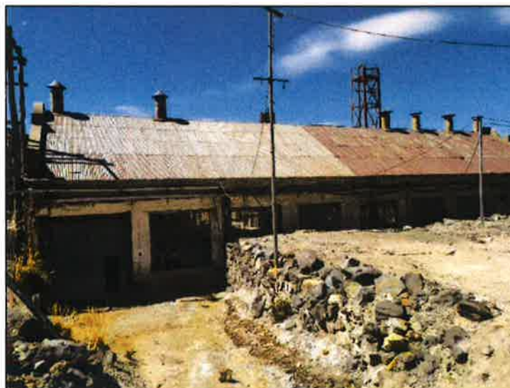
FOTOGRAFÍA 3. Exteriores de la CT Caudalosa Grande, al interior de la Unidad Minera
