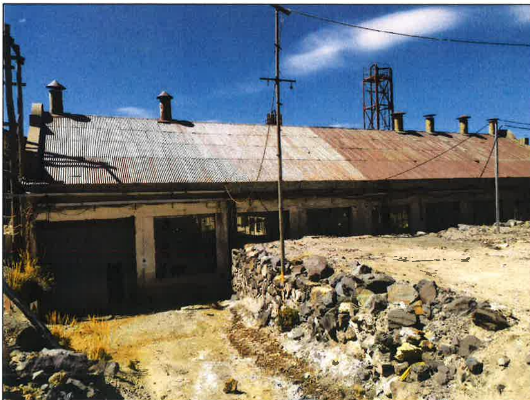
FOTOGRAFÍA 2. Central Térmica Caudalosa
