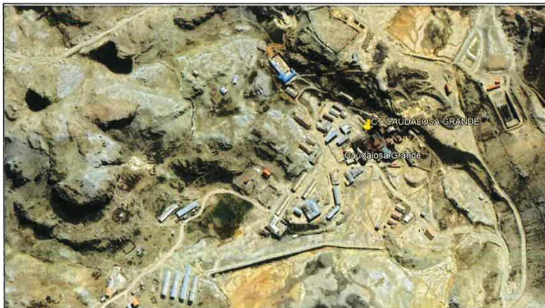
FIGURA 1. Ubicación de la Central Térmica Caudalosa Grande
