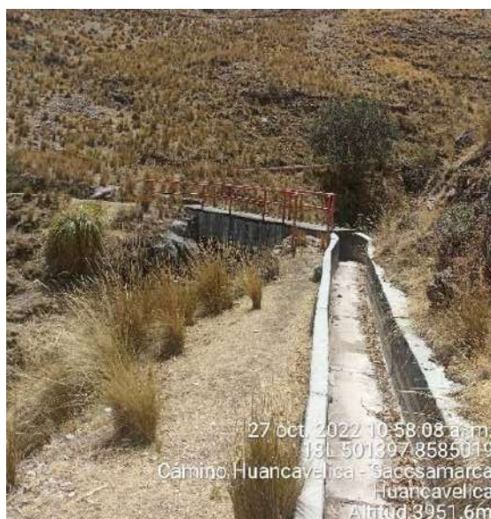
Figura 6.43. Tramo entre canal aéreo por puente y primer puente de acceso peatonal.
