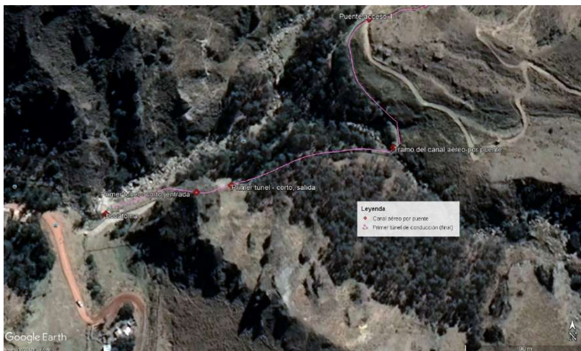
Figura 6.17. Tramo primer túnel de conducción (inicio) y canal aéreo por puente – 2021.
