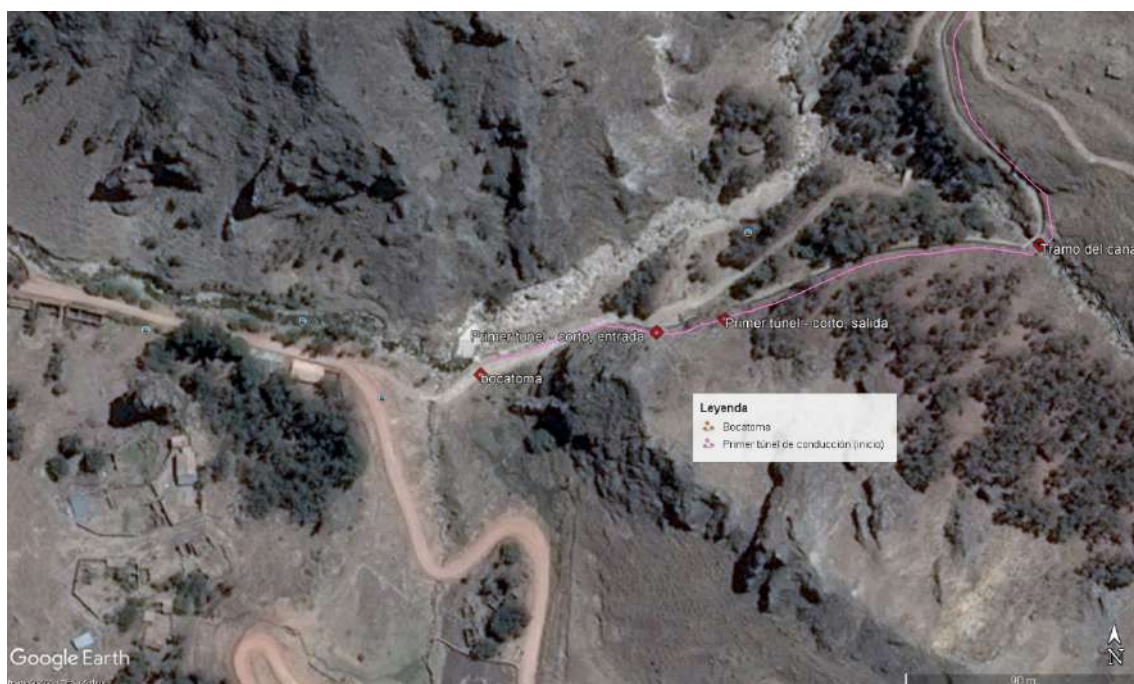
Figura 6.12. Tramo entre la bocatoma y primer túnel de conducción – 2013.
