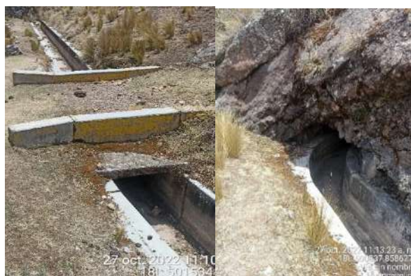
Figura 6.45. Tramo entre el segundo puente de acceso peatonal y segundo túnel de conducción (inicio).
