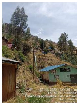
Figura 6.51. Tramo entre área de cámara de carga y casa de máquinas.
