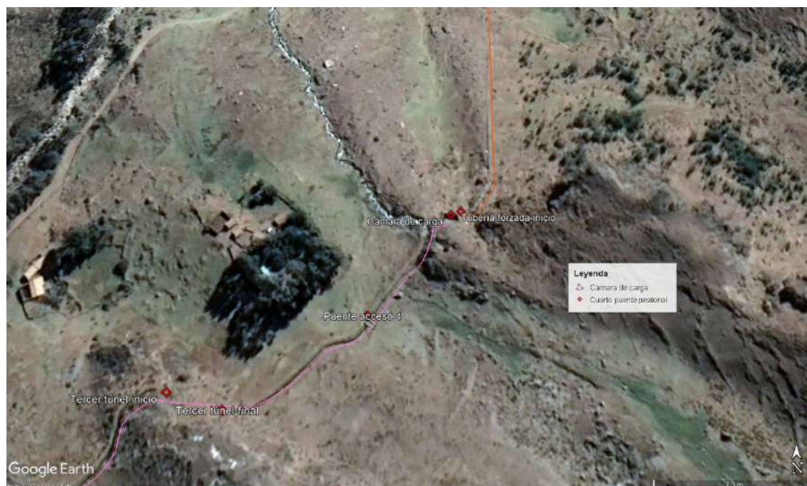
Figura 6.35. Tramo entre el cuarto puente de acceso peatonal y área de cámara de carga – 2021.
