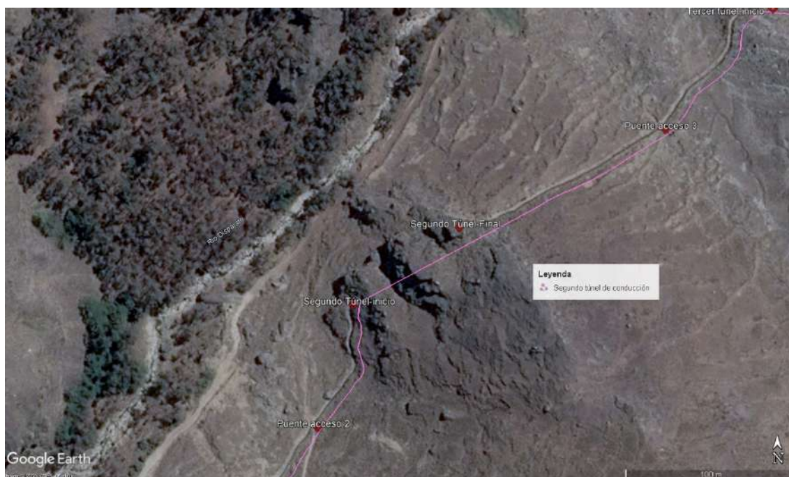
Figura 6.24. Tramo segundo túnel de conducción (Inicio-fin) – 2013.
