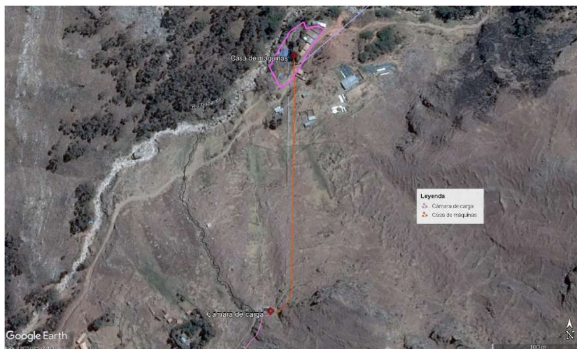
Figura 6.36. Tramo entre área de cámara de carga y casa de máquinas – 2013.
