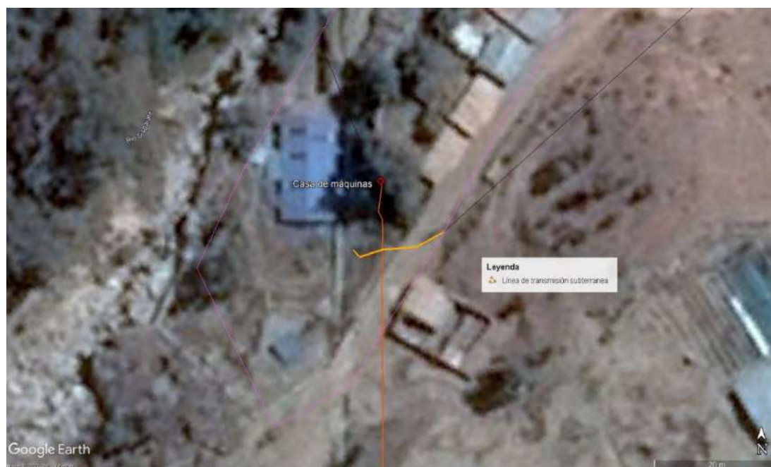
Figura 6.38. Línea de transmisión subterránea 10,9 kV – 2013.
