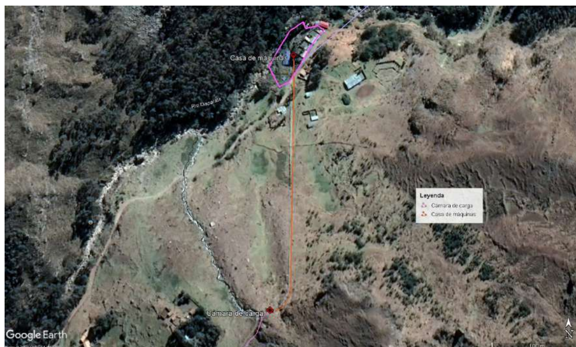
Figura 6.37. Tramo entre área de cámara de carga y casa de máquinas – 2021.
