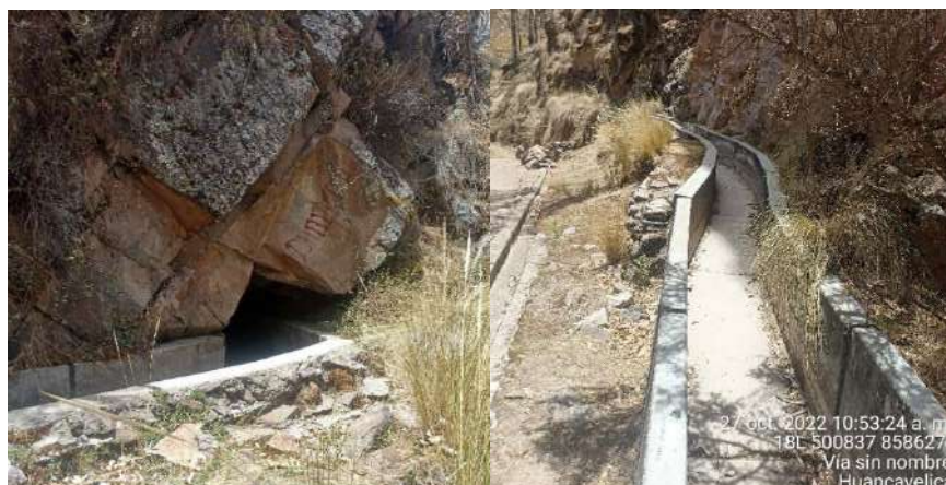
Figura 6.41. Tramo del primer túnel de conducción (Inicio-fin).
