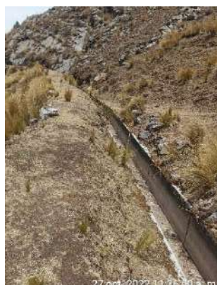
Figura 6.46. Tramo del segundo túnel de conducción (Inicio-fin).
