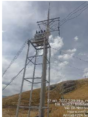
Figura 6.52. Línea de transmisión subterránea 10,9 kV.
