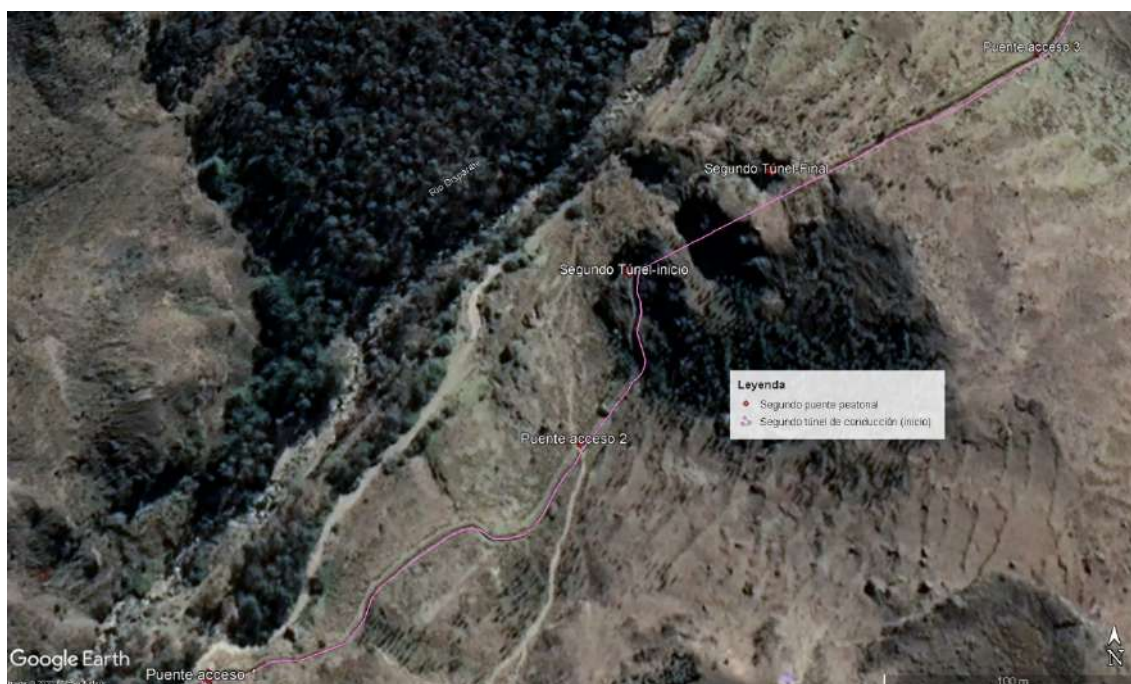
Figura 6.23. Tramo entre el segundo puente de acceso peatonal y segundo túnel de conducción (inicio) – 2021.
