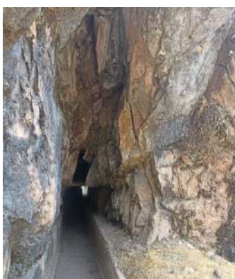
Figura 6.48. Tramo del tercer túnel de conducción (Inicio-fin).
