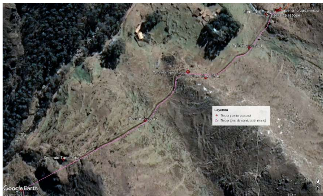
Figura 6.29. Tramo entre el tercer puente de acceso peatonal y tercer túnel de conducción (inicio) – 2021.
