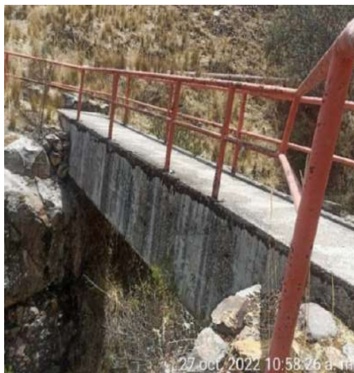
Figura 6.42. Tramo primer túnel de conducción (inicio) y canal aéreo por puente.
