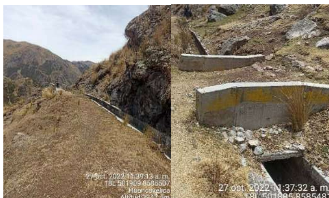
Figura 6.49. Tramo entre el tercer túnel de conducción (final) y el cuarto puente de acceso peatonal.
