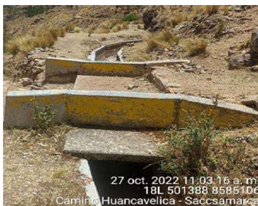
Figura 6.44. Tramo entre el primer y segundo puente de acceso peatonal.
