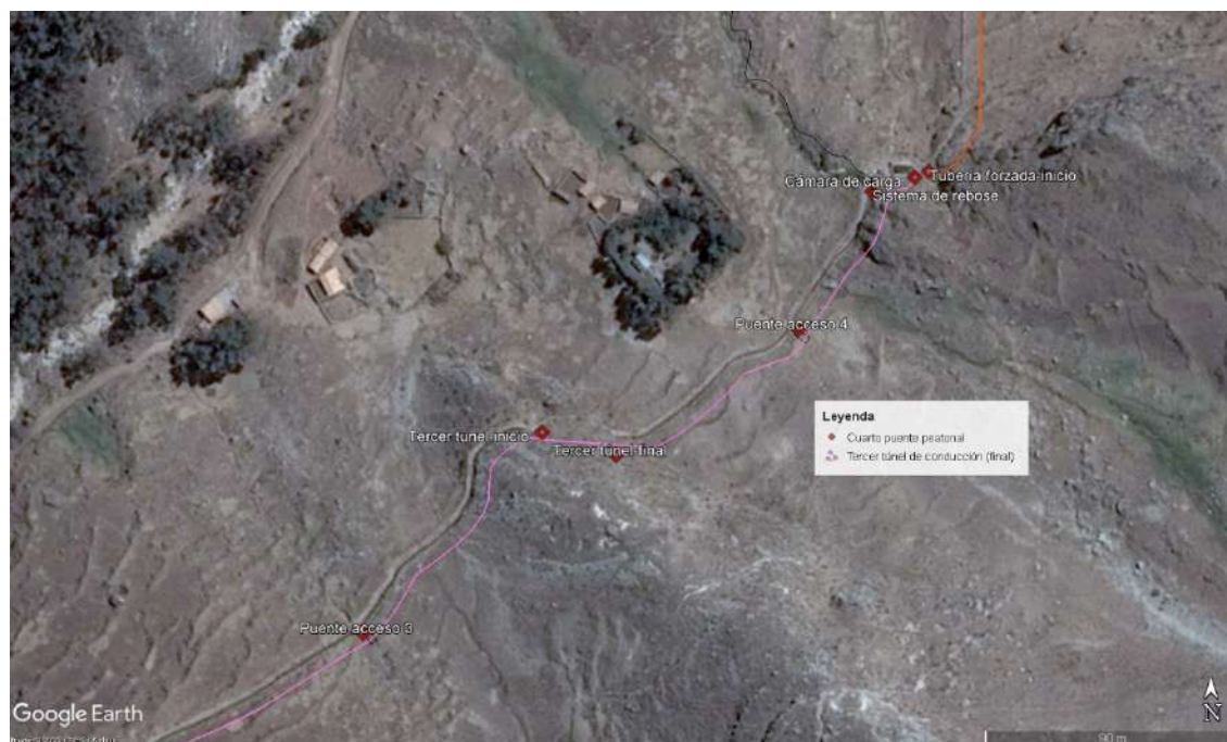
Figura 6.32. Tramo entre el tercer túnel de conducción (final) y el cuarto puente de acceso peatonal – 2013.
