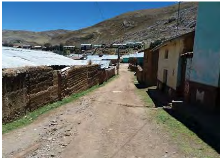
FOTO 5.7 VIVIENDAS DE TINYACCLLA
