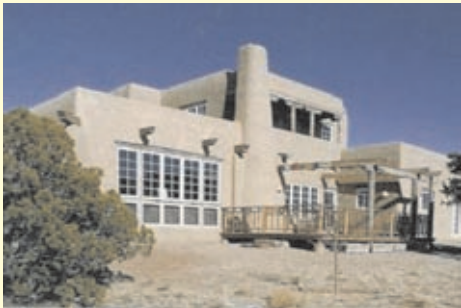
Casas con acabados de lujo, con muros de paja y encofrado de barro. Santa Fe - Nuevo México.
