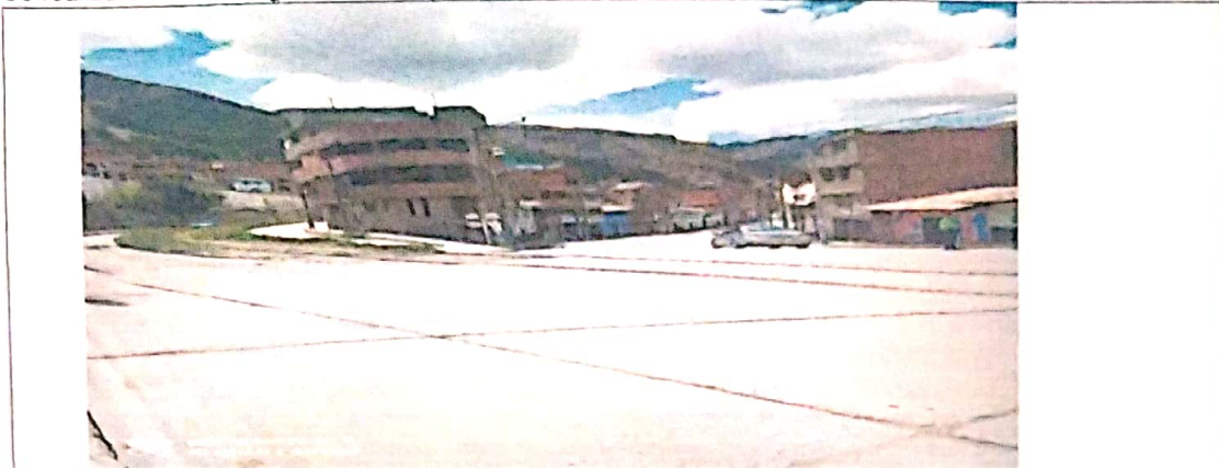
Fotografía N° 06: No se observa acumulación de residuos sólidos (papeles, bolsas, pañales, platos descartables, entre otros), pero si se observa residuos de construcción y demolición.
