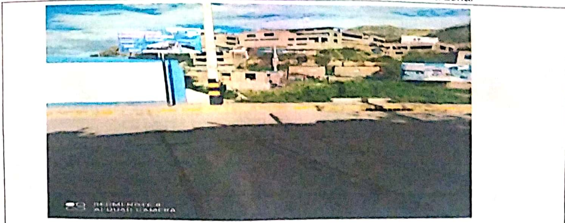
Fotografía N° 08: No se observa ningún tipo de acumulación de residuos sólidos (papeles, bolsas, pañales, platos descartables, entre otros) en la zona.
