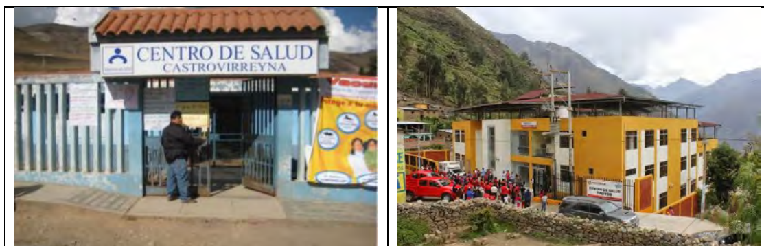
Foto N° 4.61. Vista de los centros de salud de Castrovirreyna
