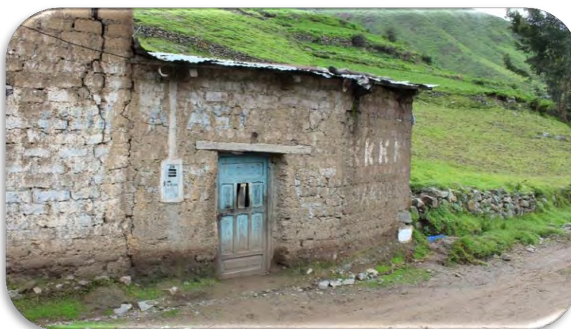
Foto N° 5.6 Vivienda en la localidad de Huangáscar
