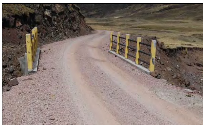
Fotografía N° 3.4. Vista del tablero - Pontón Verdesora (km 27+796)
