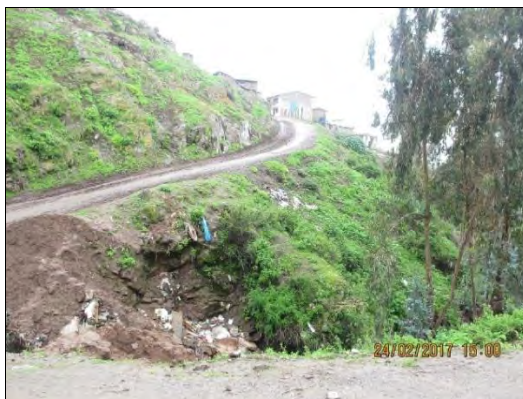
Foto N° 4.12. En quebrada cerca del CP Madeán, arrojan residuos.
