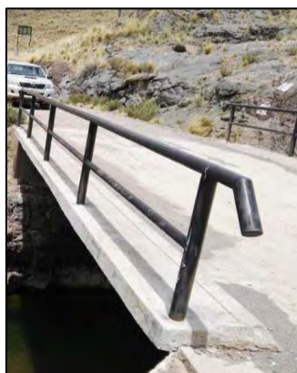
Fotografía N° 3.2. Vista de la losa
