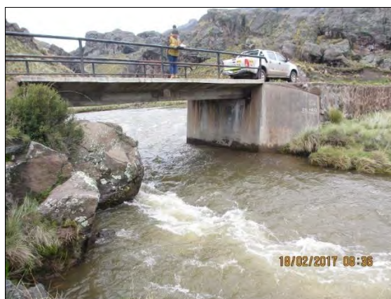
Foto N° 4.6. Río Cotay y el puente ubicado en la progresiva 17+950.
