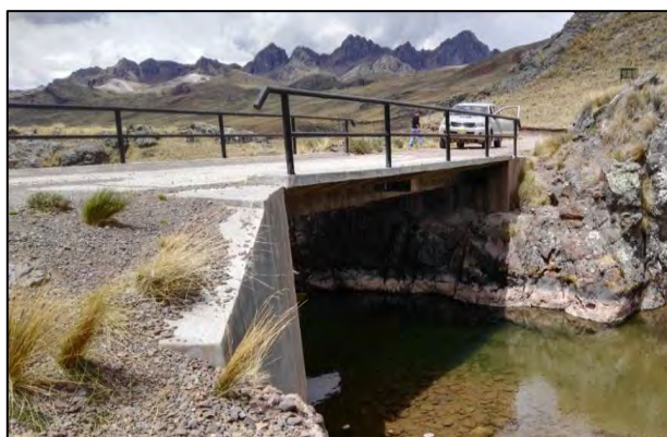
Fotografía N° 3.1. Pontón km 17+872 Cotay
