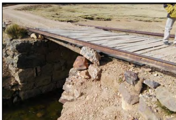
Fotografía N° 3.7. Pontón km 55+037 Tipicocha
