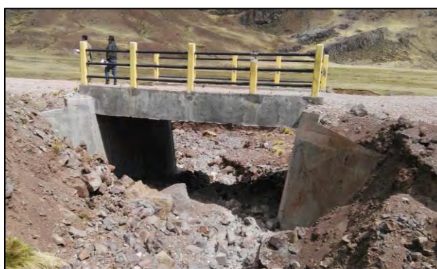
Fotografía N° 3.3. Pontón km 23+660 Isnuycocha
