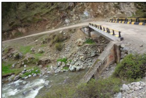
Fotografía N° 3.10. Vista del puente Madeán
