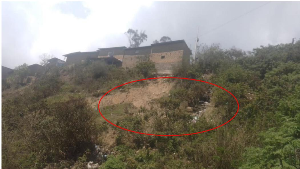
**Fotografía N.02:** Punto de descarga de aguas residuales en Salcahuasi, que genera la reptación de suelos poniendo en riesgo las viviendas y carretera principal a Surcubamba.
