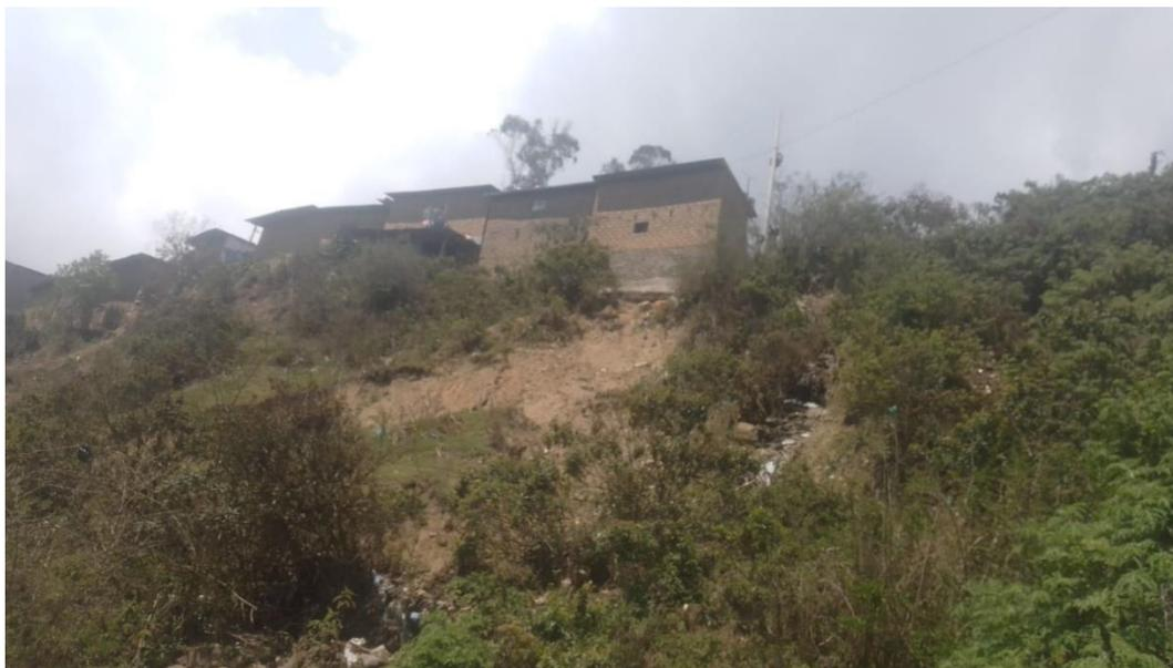
**Fotografía N° 03:** Viviendas en zona de alto riesgo, cuyo factor desencadenante es el vertimiento de agua proveniente de aguas residuales del distrito de Salcahuasi y zona inestable.
